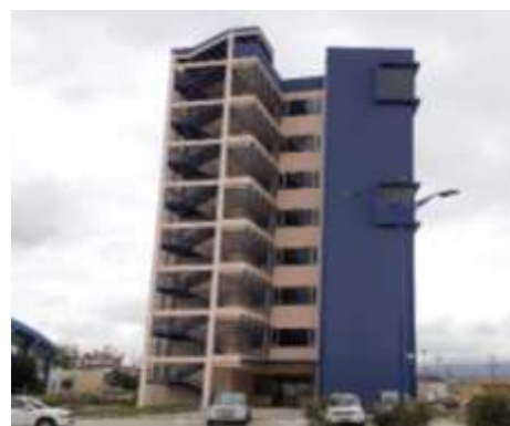
Imagen 4. Vista Lateral Izquierda Edificio L.
