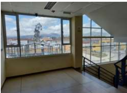
Imagen 19. Gradas de emergencia.
