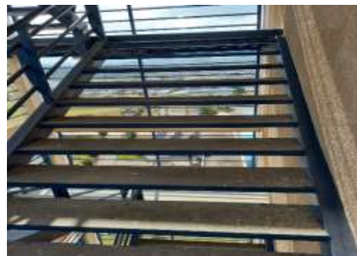
Imagen 20. Gradas de emergencia.
