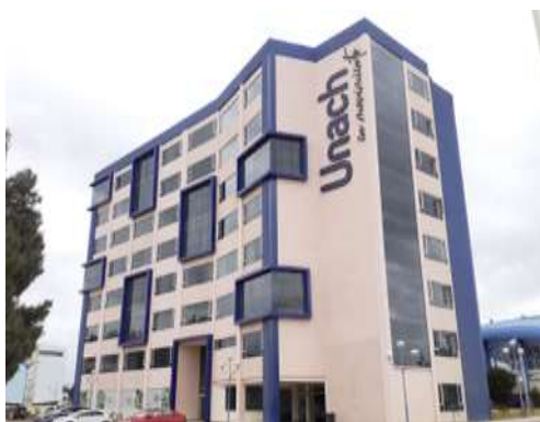
Imagen 3. Vista Lateral Derecha Edificio L.
