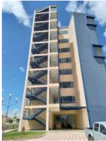
Imagen 21. Gradas de emergencia.
