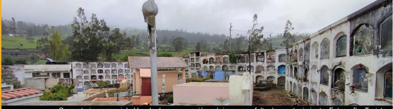
Cementerio parroquial al borde de su ocupación máxima y con falta de mantenimiento. Fotografía: Tesista.
