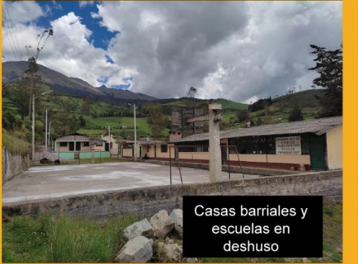
Vías secundarias en mal estado
