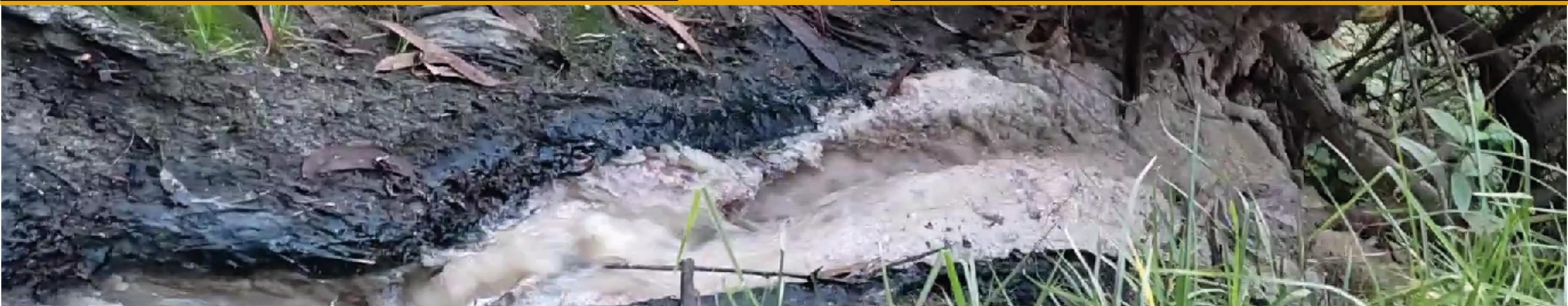
Zona de descarga del sistema de alcantarillado en la comunidad de Cachipata sin ninguna clase de tratamiento. Fotografía: Tesista.
