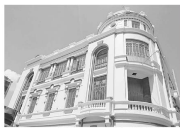
Faltan pocas semanas para que el teatro León sea entregado a Riobamba, luego de los trabajos de rehabilitación.
