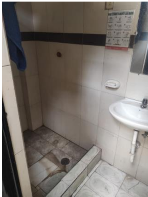
Estado actual de los baños
