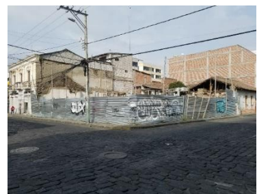
Ilustración 38: Estado actual ingreso 1
