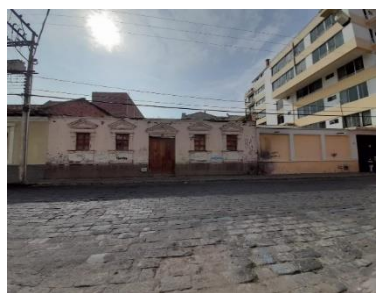
Ilustración 39: Estado actual ingreso 2
