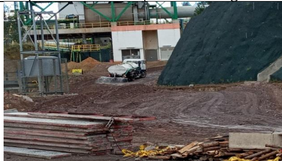
Empleo de tanquero para evitar que se desprende el material particulado volátil
