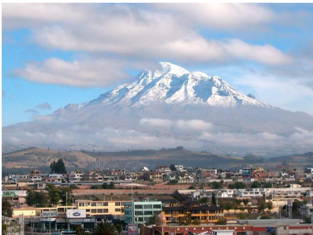
FIGURA 5.8.E. Vista panorámica cantón Riobamba 70
