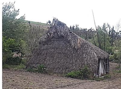
Figura 11: Foto construcción de paja. Fuente: Elaboración propia (2020)
