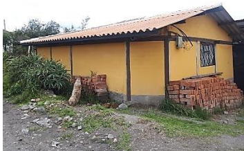
Figura 15: Foto construcción #28. Fuente: Elaboración propia (2020)
