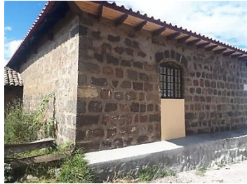
Figura 16: Foto muro portante de piedra. Fuente: Elaboración propia (2020)
