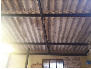
Figura 13: Foto cubierta de acero. Fuente: Elaboración propia (2020)
