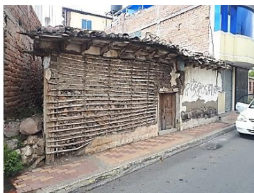
Figura 14: Foto construcción #24. Fuente: Elaboración propia (2020)
