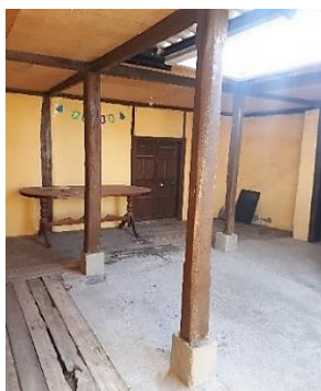
Figura 6: Foto columnas de madera. Fuente: Elaboración propia (2020)
