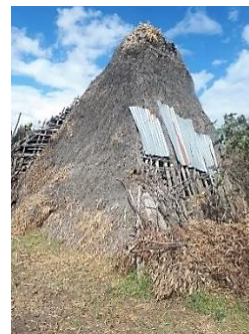
Figura 18: Foto construcción #9 Fuente: Elaboración propia (2020)
