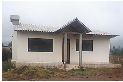
Figura 10: Foto columnas de hormigón. Fuente: Elaboración propia (2020)
