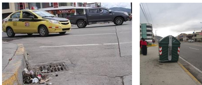
Figura 2: Contaminación por residuos solidos
