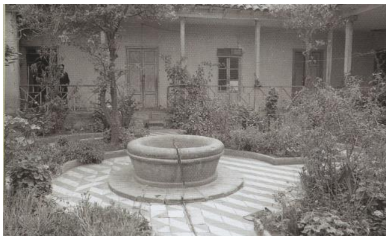
Ilustración 9 Patio Interior Casa de Bolívar antes de su restauración 1970
