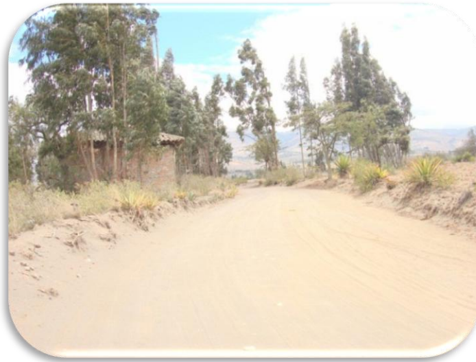
Figura. 9. RECORRIDO VÍA EXISTENTE ELABORADO POR: Darío I. Quintanilla C.
