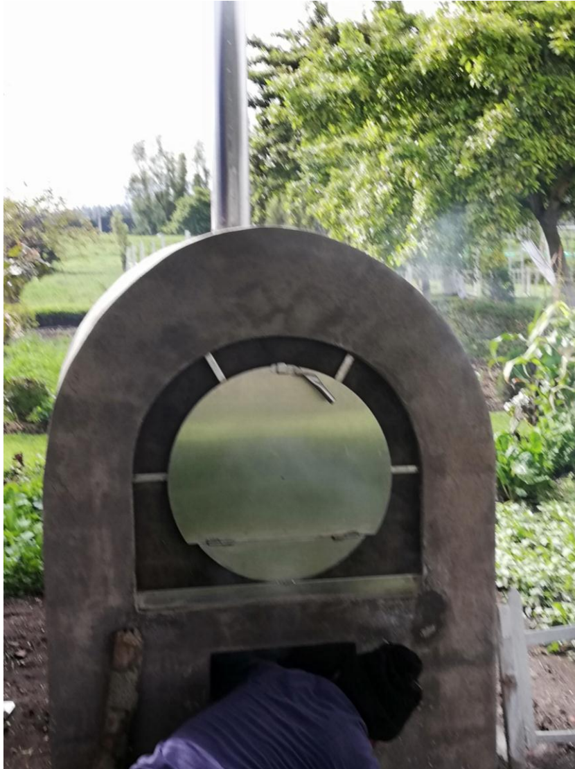
Figura 33. Comprobación de grietas
