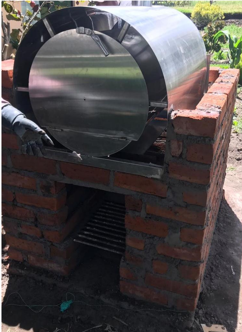
Figura 25. Colocando estructura de acero.
