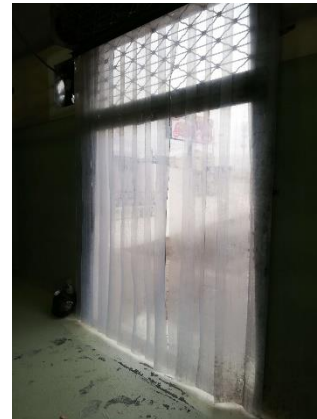
Fotografía 28. Reemplazo de persianas plásticas de cuarto de oreo
