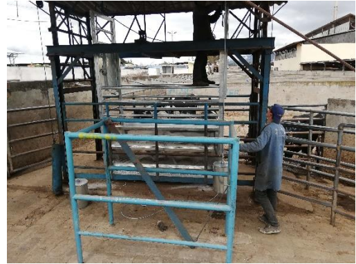
Fotografía 38. Mantenimiento de estructura de corrales de bovinos
