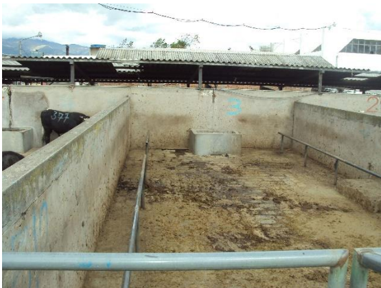
Fotografía 23. Falta de limpieza de pisos de corrales
