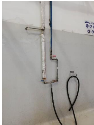
Fotografía 27. Reposición de pintura de paredes en planta de faenado de bovinos
