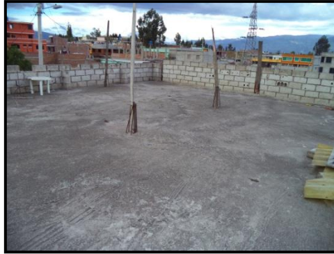
Figura 43. Losa de cubierta de la vivienda D_13_2P.
