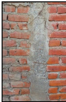
Figura 42. Estado de conservación de la vivienda D_13_2P.
