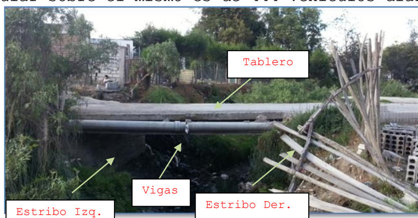
Figura 6. Partes constitutivas del PUENTE SOBRE LA QUEBRADA BUNQUE.
