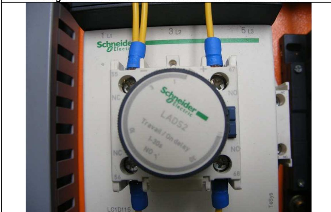
Fotografía 14. Relé de Retardo, conexión Estrella-Triángulo
