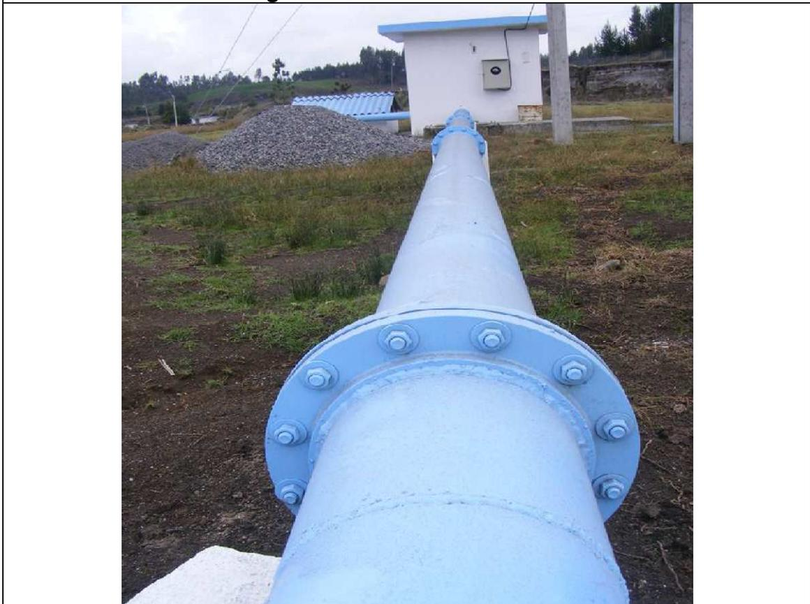
**Fotografía 6. Tubería de Hierro Dúctil**
