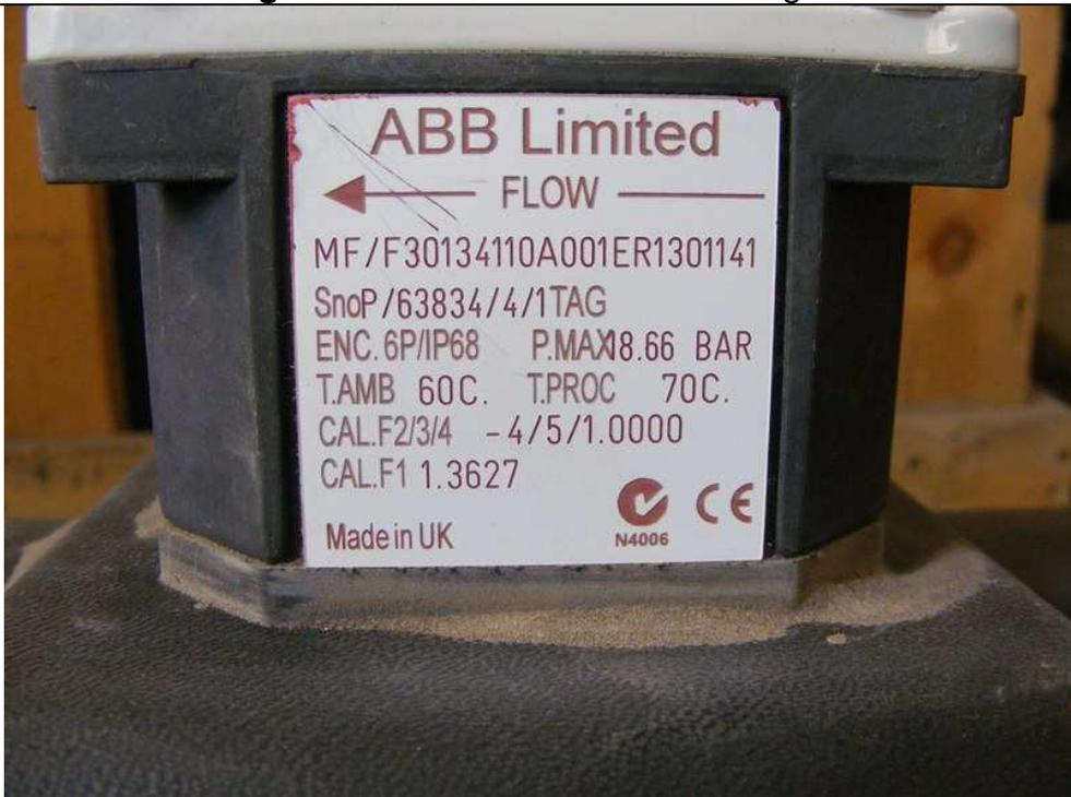
**Fotografía 10.** Caudalímetro Electromagnético
