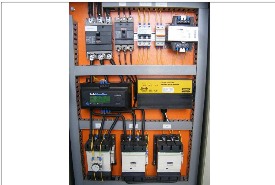
Fotografía 13. Sistema de Protección de Fases Franklin Electric
