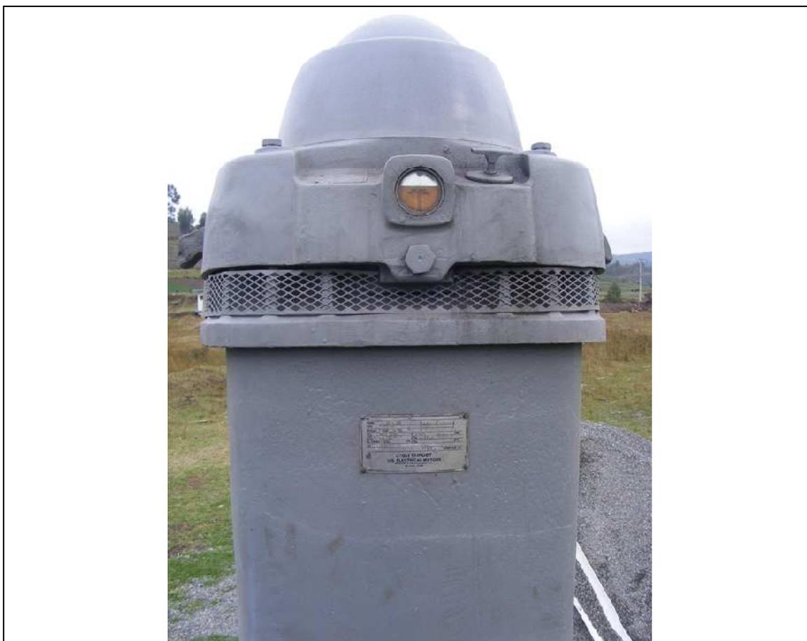
**Fotografía 1.** Motor Vertical AC - US Electrical Motors
