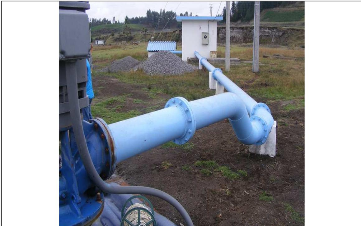
**Fotografía 5. Tubería de Hierro Dúctil**
