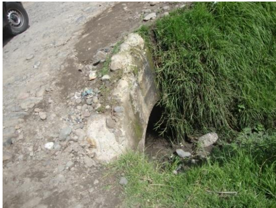
Fotografía 12: Alcantarilla Tipo Circular Columbe – San Guissel
