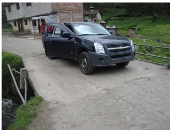
Fotografía 16: Puente sobre el Rio Sasapud. Marzo 2010 Columbe San Guissel
