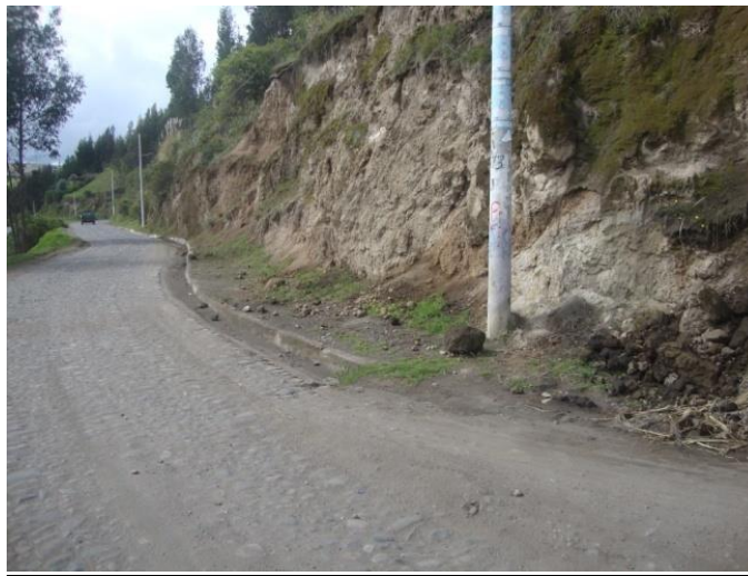
Fotografía 26: Peinado de Taludes
