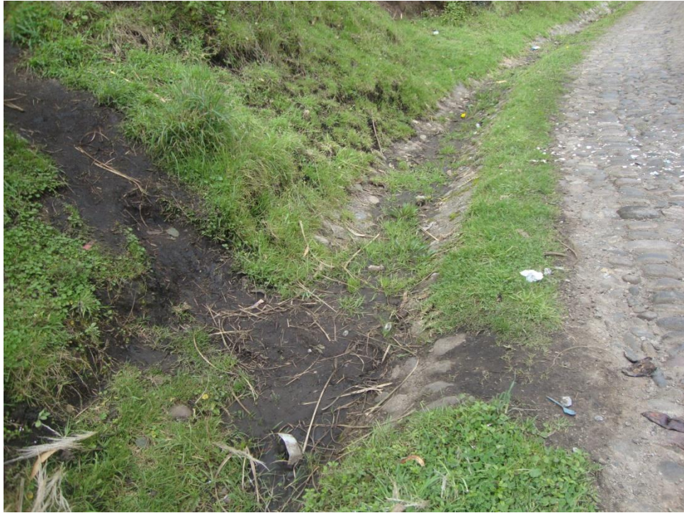
LIMPIEZA DE CUNETETA Y ENCAUSAMIENTO ABSCISA 0+940
