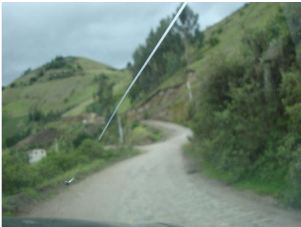
ESTADO ACTUAL DEL CAMINO EN LA ABSCISA 6+400
