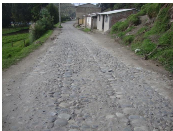
Fotografía 4: Vías de Acceso en Estudio
