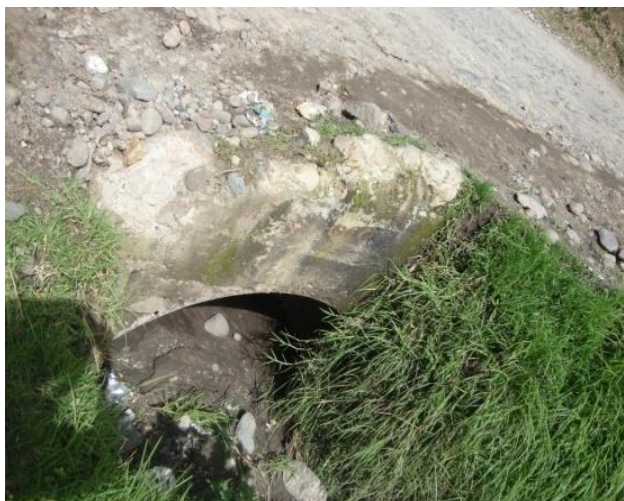
Fotografía 28: Limpieza de Alcantarillas.
