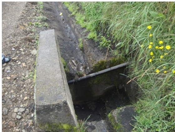
Fotografía 14: Alcantarilla revestida Lirio – Pichiloma - Yavirac
