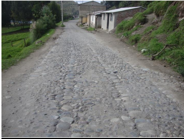
Fotografía 25: Bacheo de Calzada
