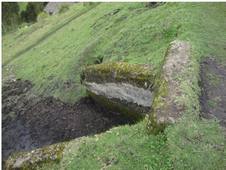
ALCANTARILLA QUE SE ENCUENTRA FUNCIONANDO ABSCISA 3+450
