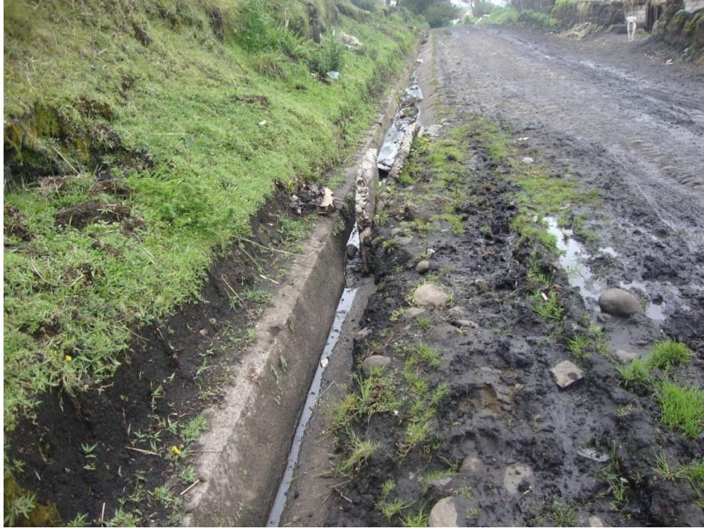
LIMPIEZA Y ENCAUSAMIENTO DE CUNETAS ABSCISA 4+120
