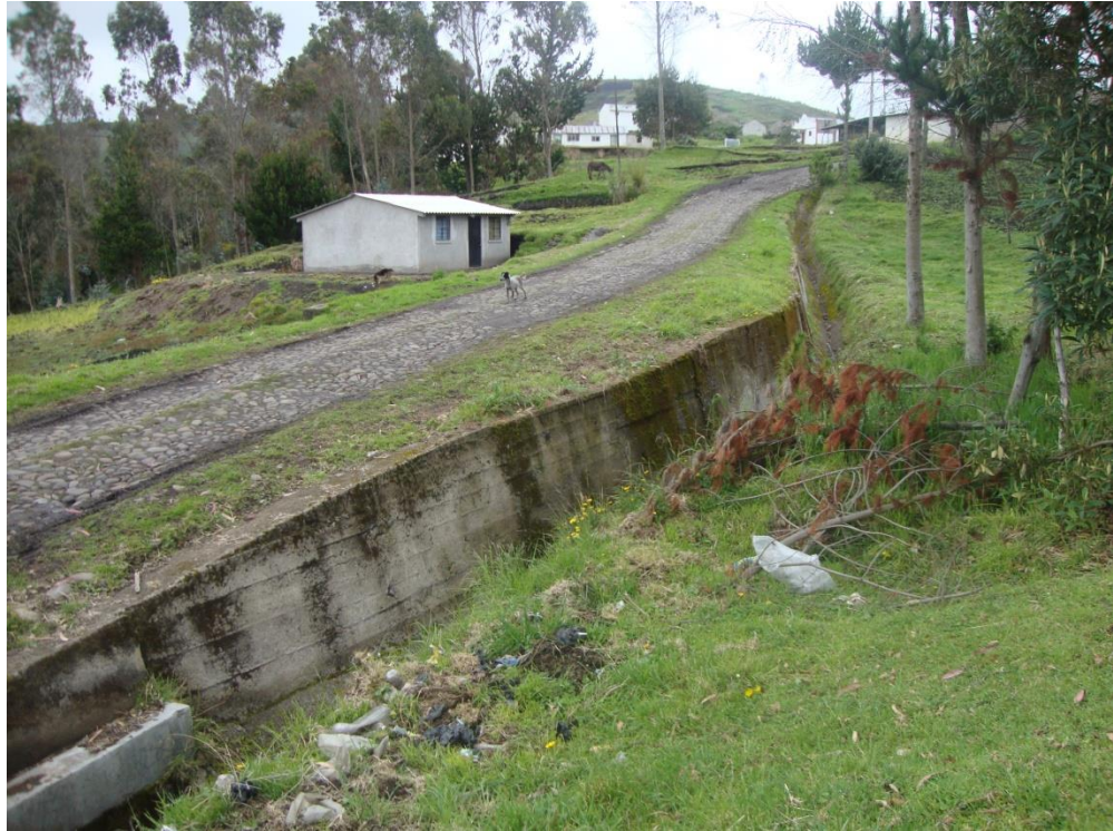
MURO DE HORMIGÓN ABSCISA 5+080
