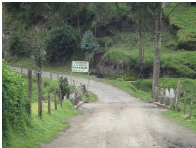
Fotografía 30: Limpieza de Puente y Pontones
