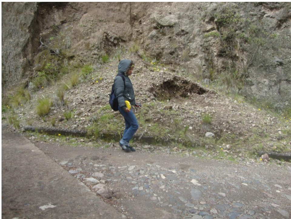
DERRUMBE DE SUELO NATURAL ABSCISA 1+340
