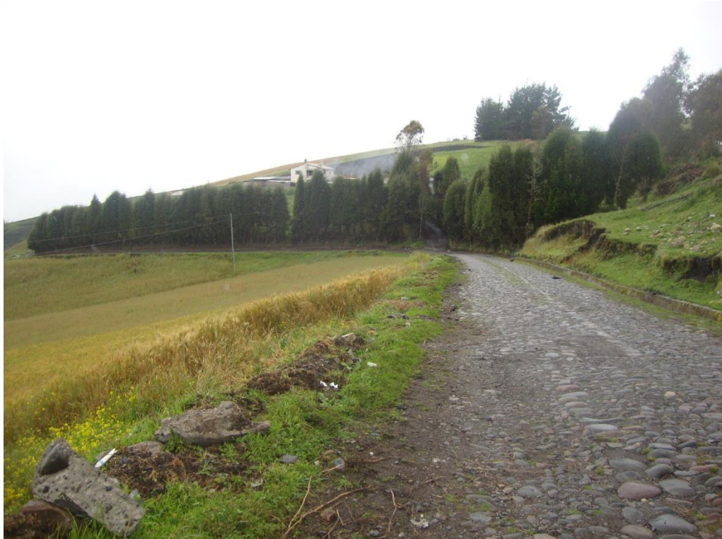
ESTADO ACTUAL DE CAMINO VECINAL 10+040
