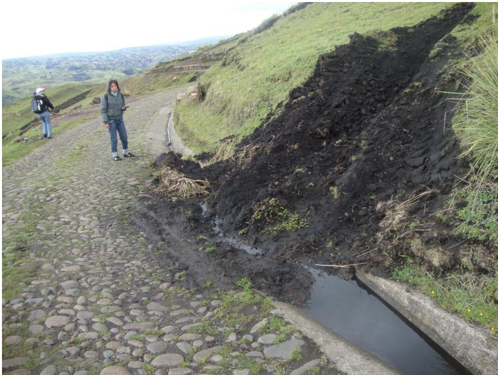
DESLIZAMIENTO A LA MESA DEL CAMINO ABSCISA 5+870
