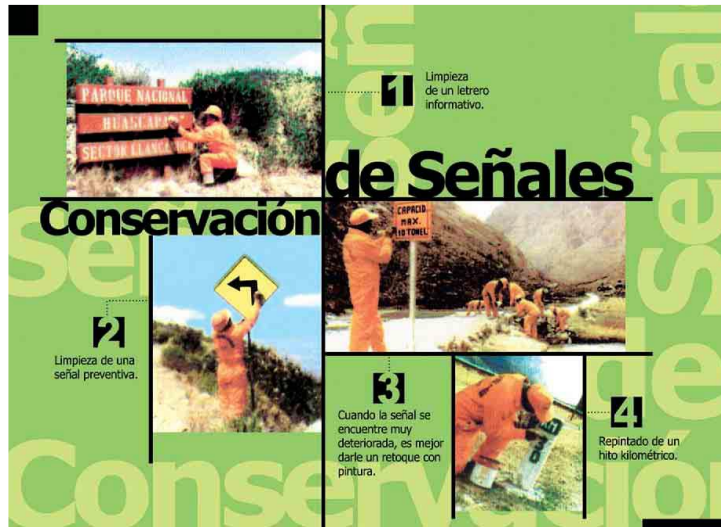
Fotografía 33: Mantenimiento de Señales
