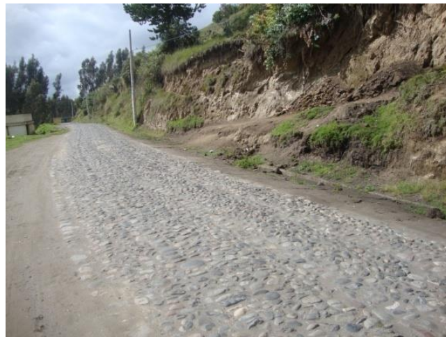
Fotografía 29: Limpieza de Badenes
