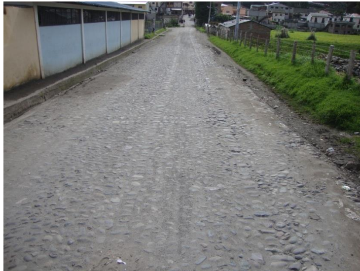
Fotografía 23: Calzada del Camino
