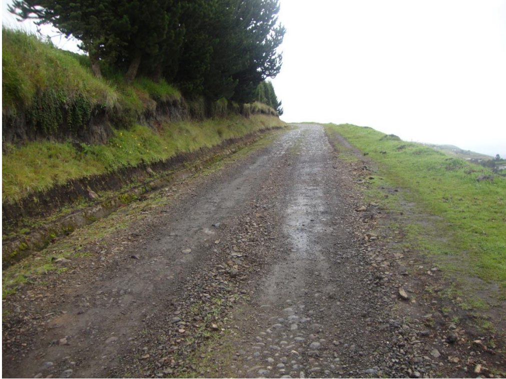
REPOSICION EN LA CALZADA CON MATERIAL (LASTRE)
