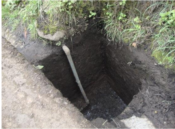
Fotografía 15: Alcantarilla Tipo Cuadrada Columbe San Guissel.
