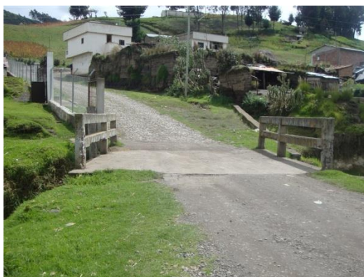
Fotografía 17: Puente en buen estado. Junio 2010 Castug Tungurahuilla Chacabamba
