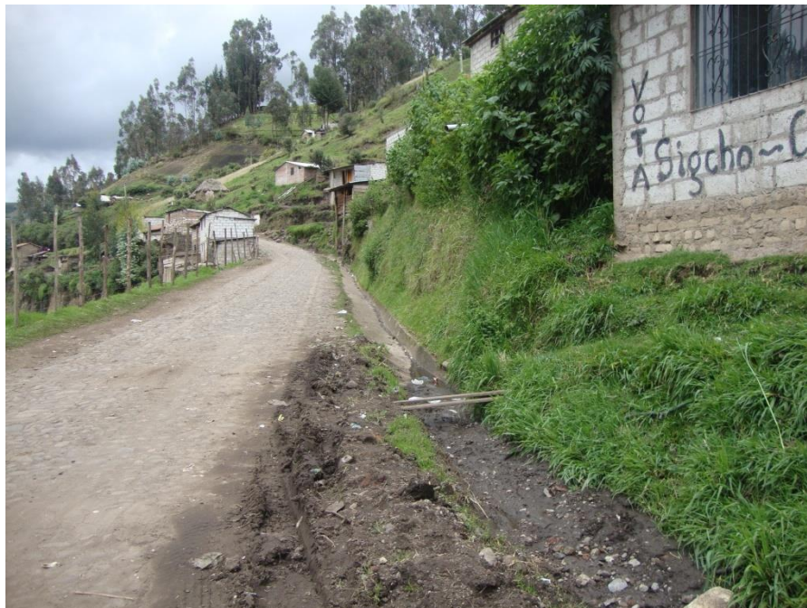
ALCANTARILLA ABSCISA 7+350 (LIMPIEZA DE ALCANTARILLA Y ENCAUSAMIENTO)
