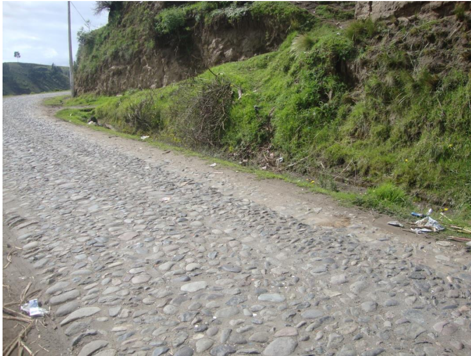
ESTADO ACTUAL DEL CAMINO EN LA ABSCISA 7+00
