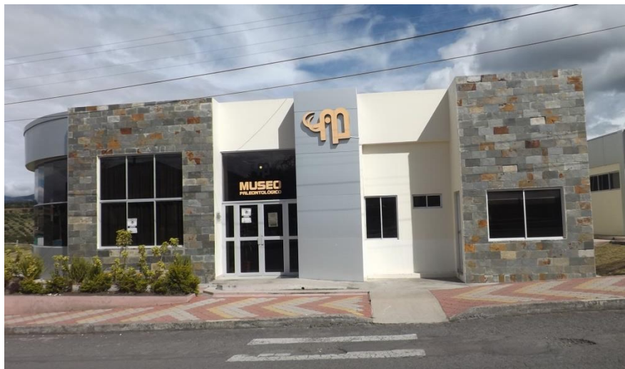
Foto N°1 Vista de frente de las instalaciones del museo
