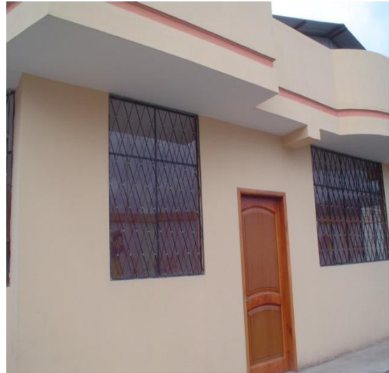
Fotografía 20. Vista frontal. Enero/2010
