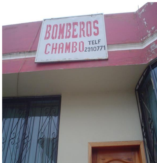
Fotografía 35. Vista frontal. Enero/2010
