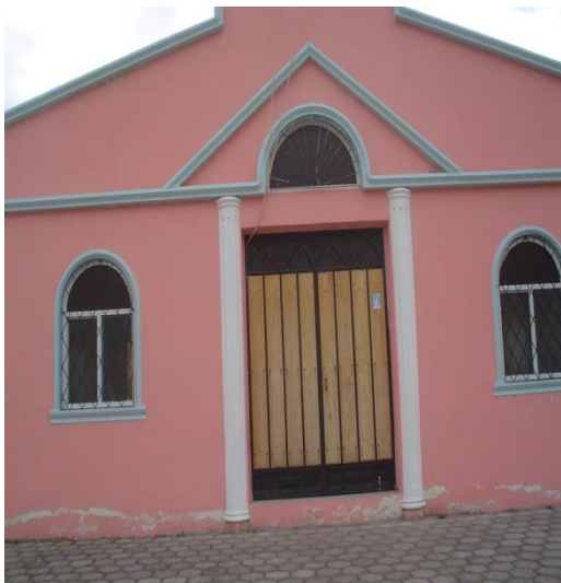
Fotografía 47. Vista frontal. Enero/2010
