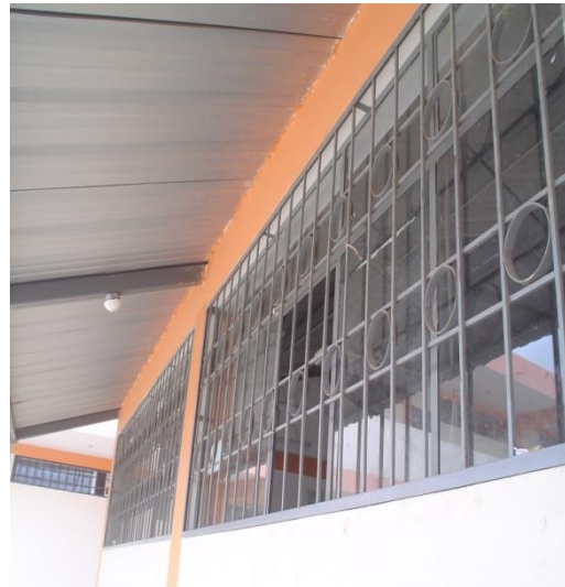
Fotografía 28. Vista lateral. Enero/2010
