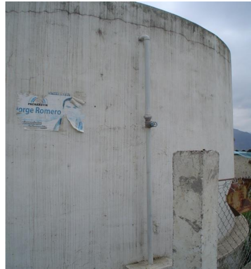
Fotografía 74. Tanque de reserva. Enero/2010
