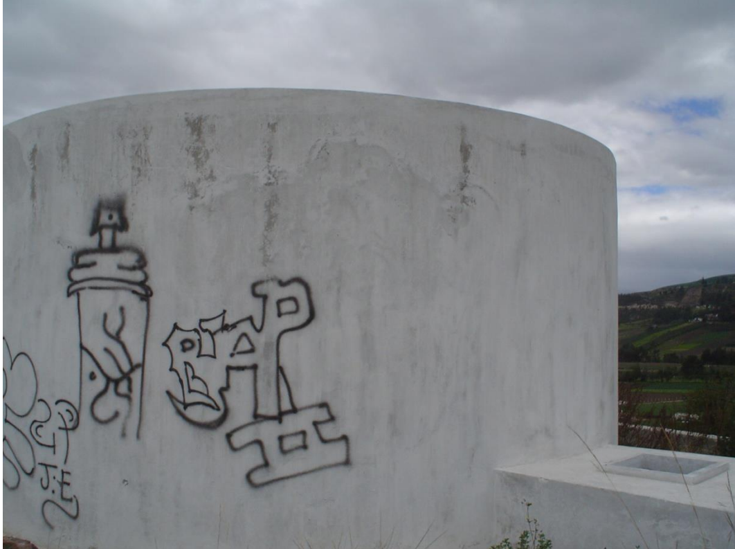
Fotografía 88. Tanque de reserva. Enero/2010
