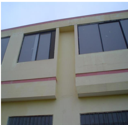
Fotografía 51. Vista frontal. Enero/2010
