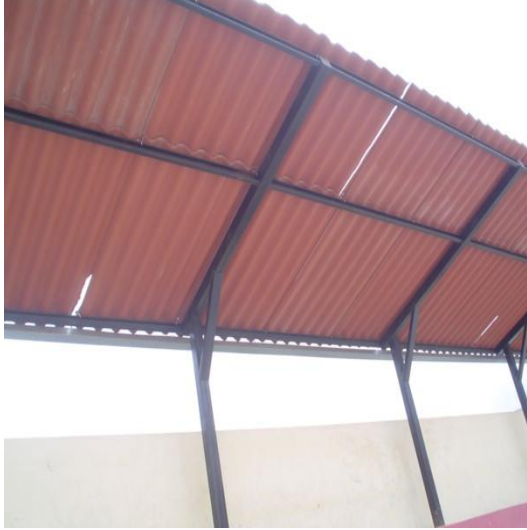
Fotografía 31. Cubierta graderíos. Enero/2010
