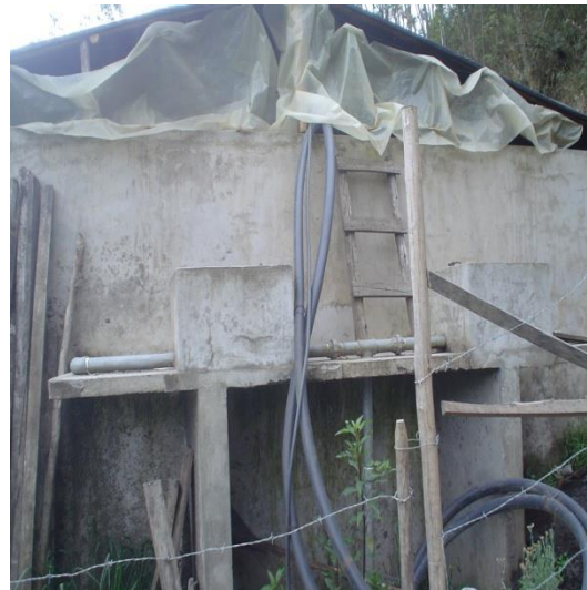
Fotografía 66. Vista lateral. Enero/2010
