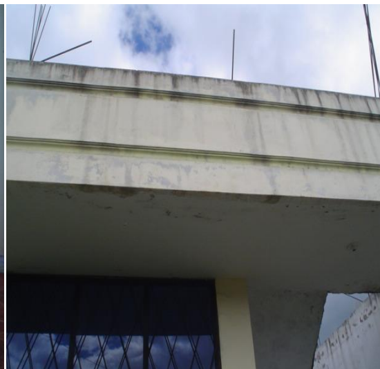
Fotografía 58. Vista frontal. Enero/2010
