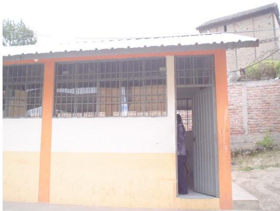
Fotografía 27. Vista frontal. Enero/2010
