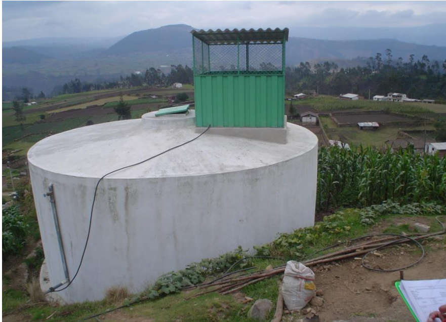
Fotografía 81. Tanque de reserva. Enero/2010
