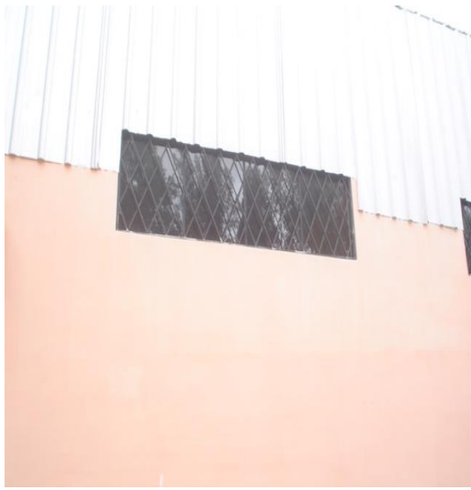
Fotografía 59. Vista lateral. Enero/2010
