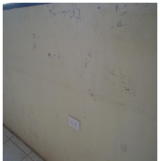
Fotografía 54. Pintura Interior. Enero/2010
