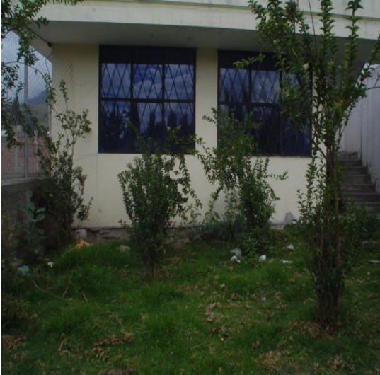
Fotografía 55. Vista lateral. Enero/2010
