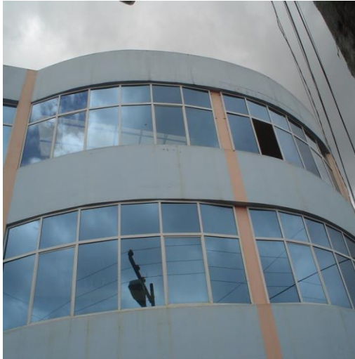
Fotografía43. Vista frontal. Enero/2010
