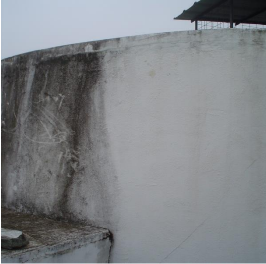
Fotografía 69. Tanque de reserva. Enero/2009
