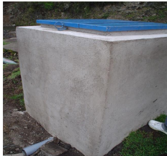
Fotografía 87. Válvula de desagüe. Enero/2010
