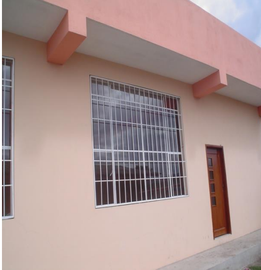
Fotografía 15. Vista lateral. Enero/2010
