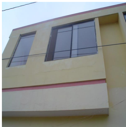
Fotografía 52. Vista lateral. Enero/2010
