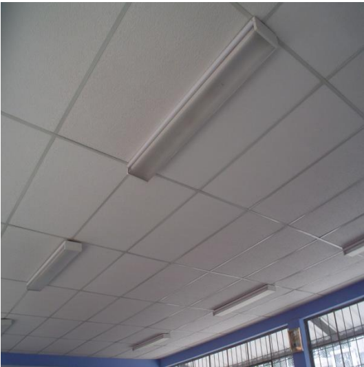
Fotografía 26. Cielo raso e iluminación. Enero/2010
