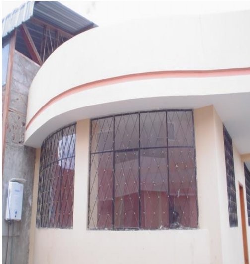
Fotografía 19. Vista lateral. Enero/2010
