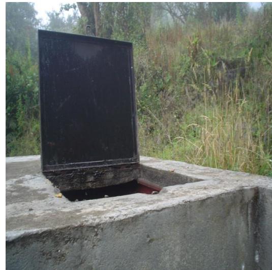
Fotografía 72. Tanque de captación. Enero/2009
