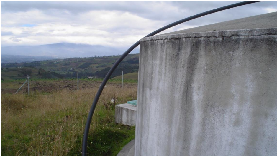
Fotografía 82. Tanque de reserva. Enero/2010
