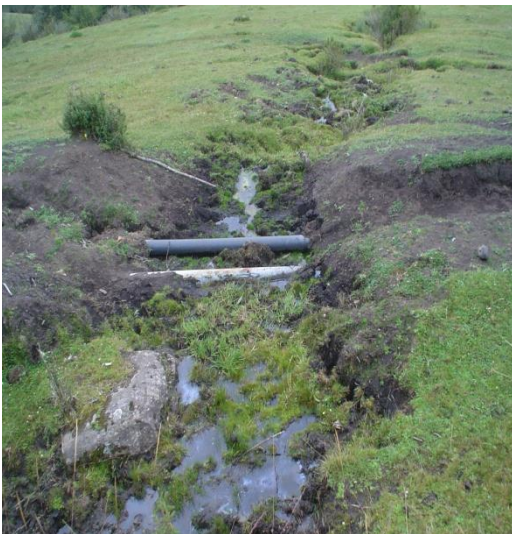
Fotografía 86. Tubería de conducción. Enero/2010
