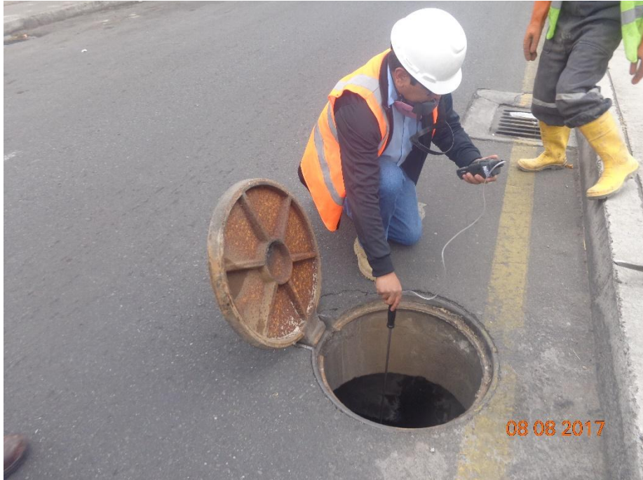
Fotografía N.3.10. Prueba de evaluación de atmosfera interior.
