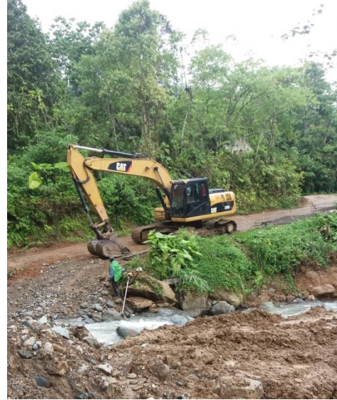
Replanteo estribo izquierdo
