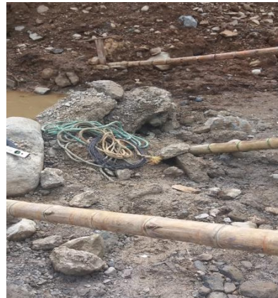
Figura 14. Órdenes de re trabajo Puente Huagra-Hurco
