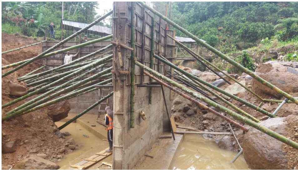
Apuntalamiento muro de pantalla y muro de Ala.
