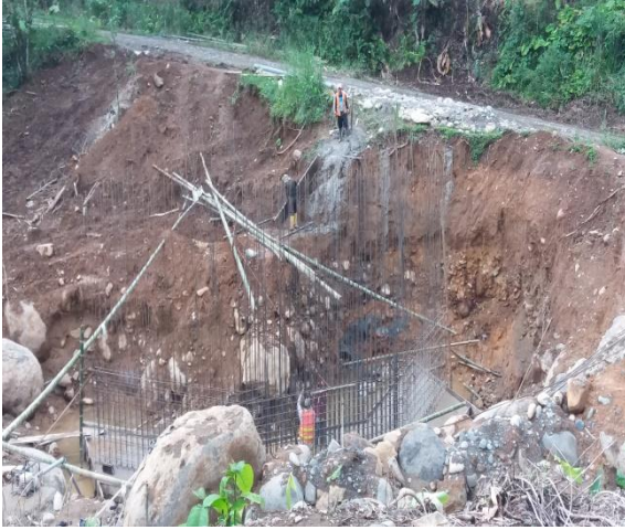
Apuntalamiento muro de pantalla y muro de Ala.
