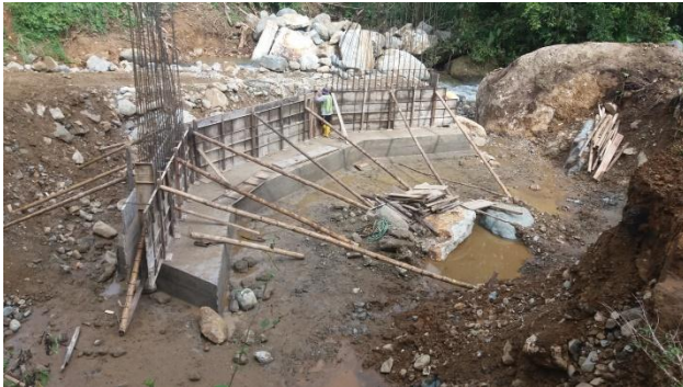
Encofrado muro de pantalla Estribo derecho
