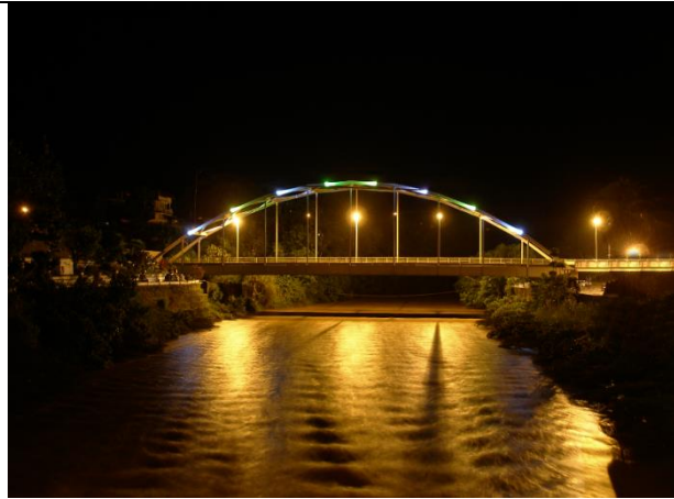
Fotografía: Puente carrosable
