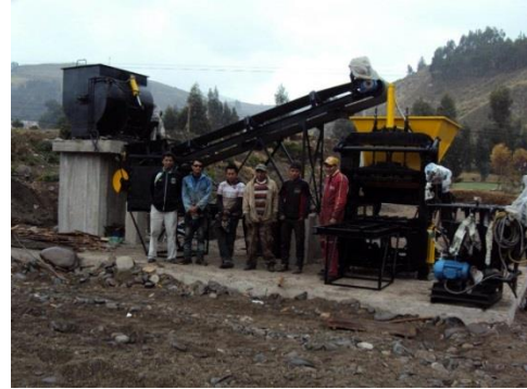
Montaje de la maquina F5000C en el lugar donde va a Funcionar
