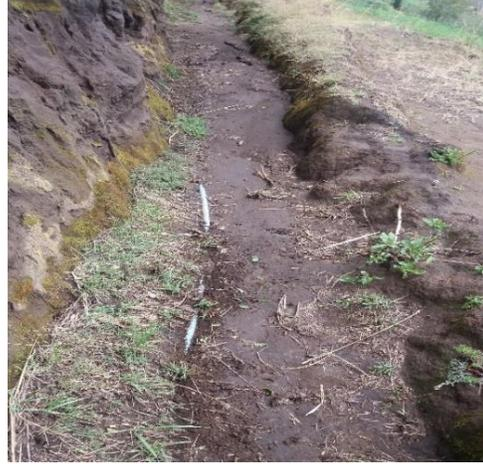
Red de distribución, tubería PVC de 32mm
