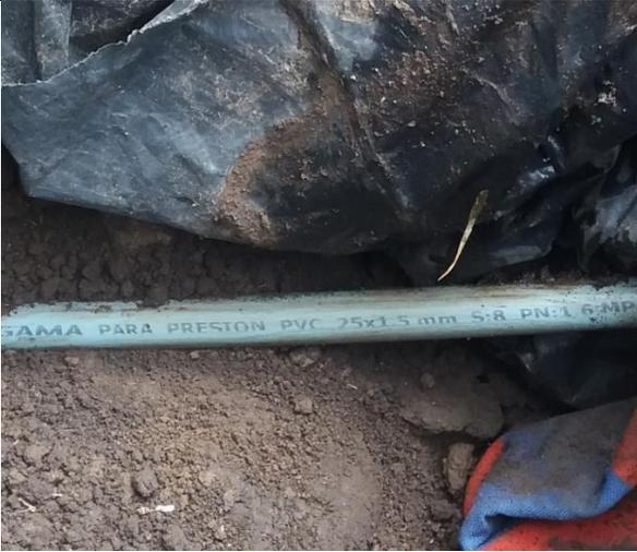
Red de distribución, tubería PVC de 25mm
