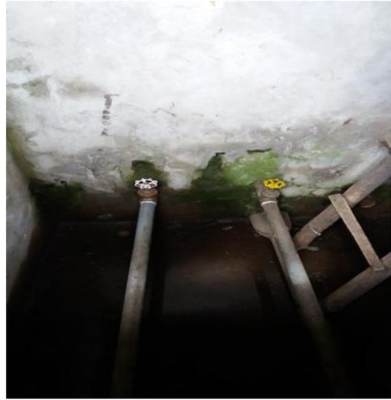
Caja de válvulas de tubería de distribución y desagüe Hg de 2 pulg.
