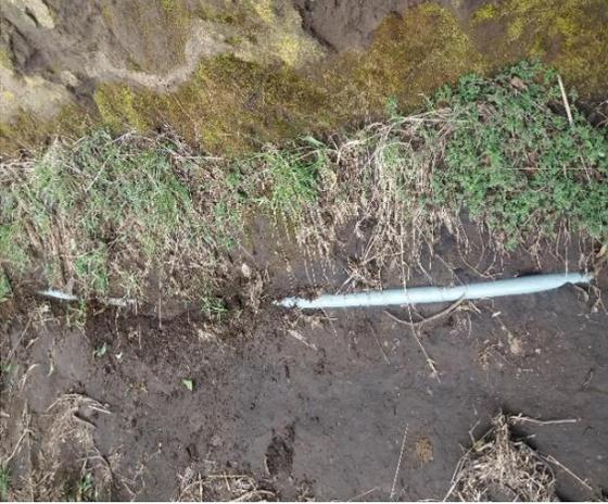
Red de distribución, tubería PVC de 32mm
