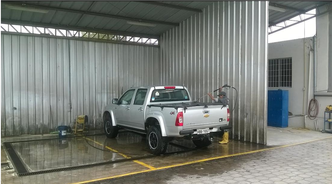
Ilustración 69: Área de lavado
