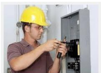
Ilustración 50: Revisión de instalación eléctrica
