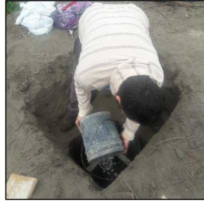
Figura 34. Colocación de grava en el infiltrómetro de cilindro doble
