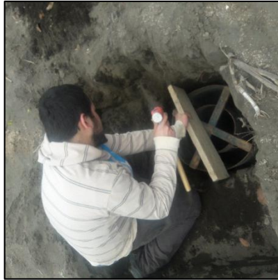
Figura 15. Hincado del cilindro
