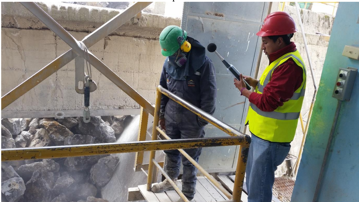
Medición del nivel de ruido en la trituradora primaria.
