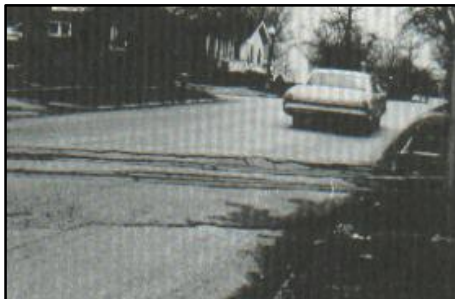
Ilustración 17. Desnivel en la vía por cruce de ferrocarril. Fuente: ING. Luis Vásquez, INGE PAV, p 36, Manizales, 2002.
