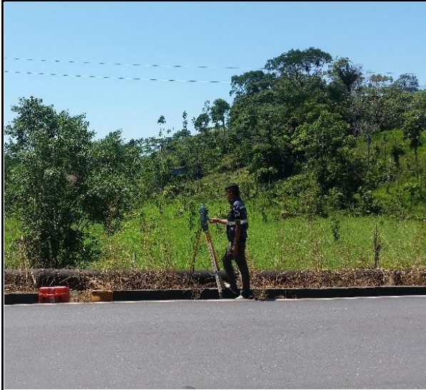
Levantamiento topográfico en la vía
