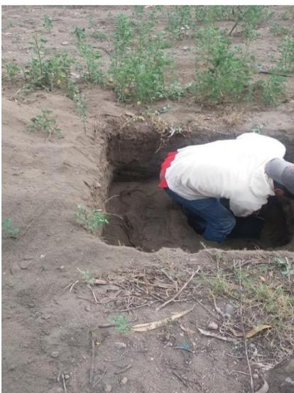
Excavación calicata de (0.5x0.5x0.5) m
