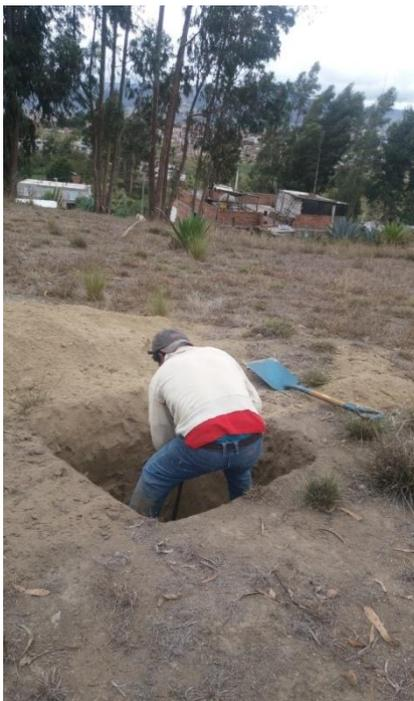
Excavación calicata de (1x1x0.5) m
