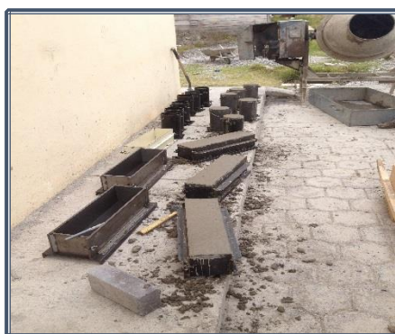
Fotografía 8.15: Elaboración de vigas de hormigón convencional
