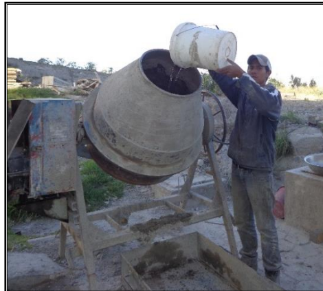
Figura 27. Colocar la tercera parte faltante de agua en la concretera
