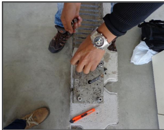
Figura 53. Atornillado de los pernos con las tuercas
