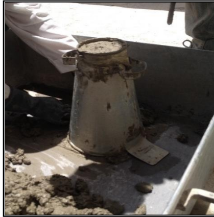
Figura 16. Retiro del exceso de hormigón (asentamiento del hormigón estado fresco)
