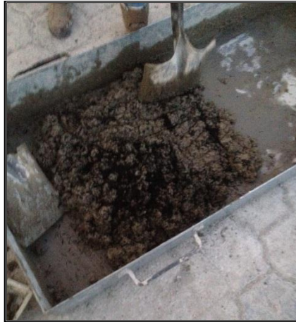
Figura 11. Adición de fibrillas recicladas de neumáticos
