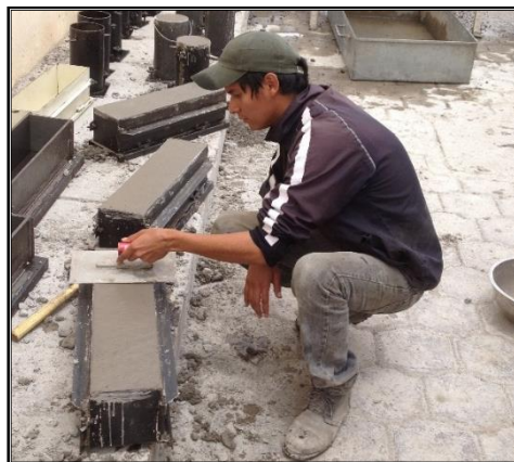
Figura 31. Acabado final de viga con la liana
