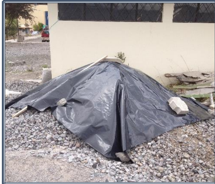
Fotografía 8.7: Precaución de mantener el estado actual del agregado grueso
