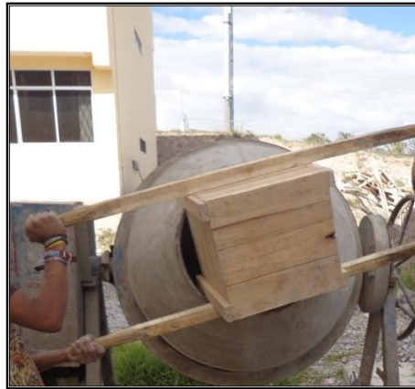
Figura 26. Colocar la cuarta parte faltante de ripio triturado en la concretera
