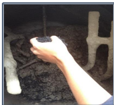
Fotografía 8.17: Vertido de FRN en la mezcla.
