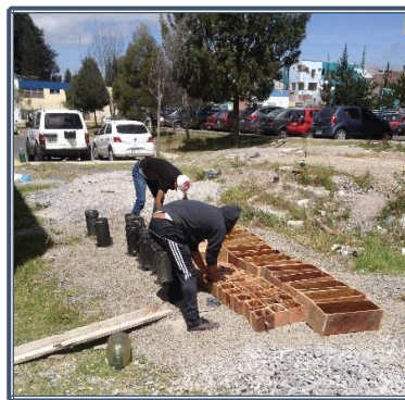
Fotografía 8.50: Engrasado de moldes, previo a fundición de hormigón
