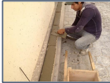
Fotografía 6.8: Lisado de acabado final en vigas simplemente armadas con hormigón convencional
