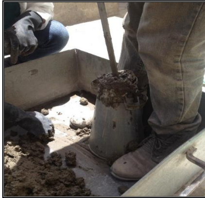
Figura 14. Compactado con varilla de apisonado (asentamiento del hormigón estado fresco)
