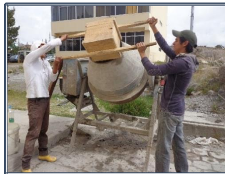
Fotografía 6.4: Colocación de agregados en la concreteira
