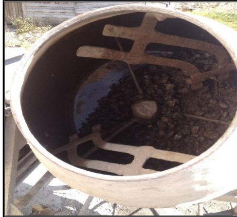
Figura 22. Colocar los 3/4 de ripio triturado en concreteira
