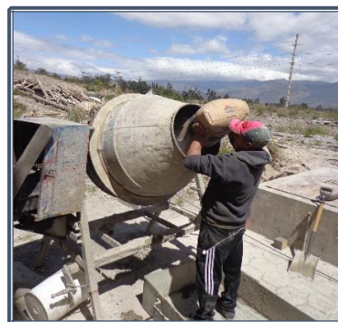
Fotografía 8.52: Colocación del cemento en conetera
