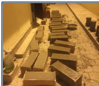
Fotografía 8.58: Fabricación de vigas
