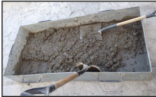
Figura 10. Mezcla del hormigón.
