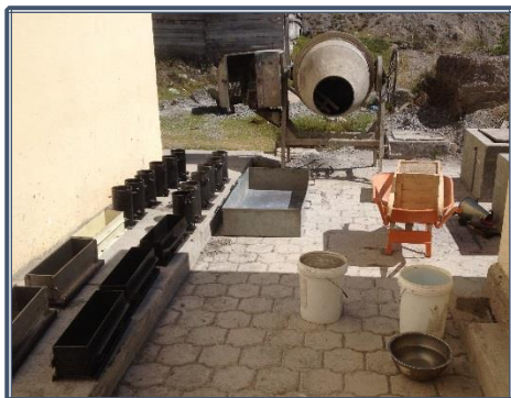
Fotografía 8.13: Preparación de equipos y materiales para la producción de probetas ( cilindros y vigas)
