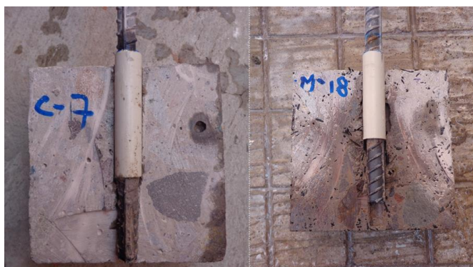
Figura 77. Desprendimiento de la varilla corrugada después del ensayo de adherencia.
