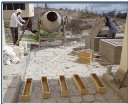
Fotografía 6.3: Moldes de vigas rectangulares
