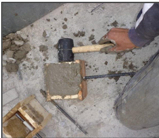
Figura 45. Compactación con 5 a 7 golpes con el mazo por cada capa y luego enrazar
