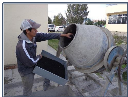
Fotografía 8.53: Esparcido de FRN para la obtención de hormigón modificado
