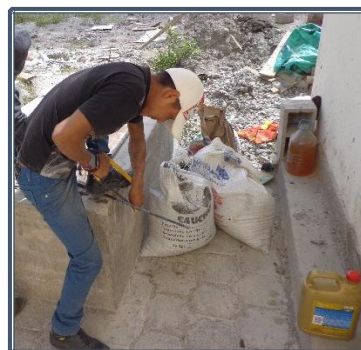
Fotografía 8.48: Corte de varilla de 10mm, Long 300 mm
