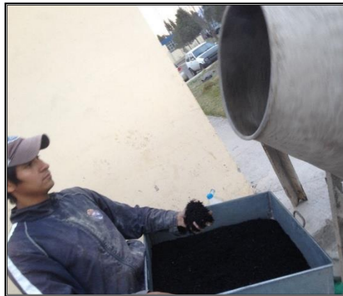
Figura 25. Colocar toda la cantidad de fibrillas recicladas de neumático en la concretera
