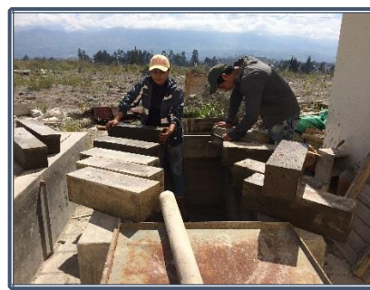
Fotografía 8.66: Desmolde de vigas
