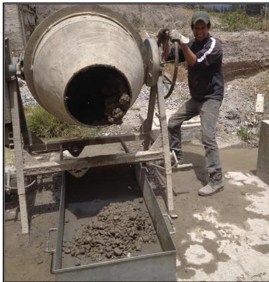
Figura 29. Vertido del hormigón a la superficie plana no absorbente
