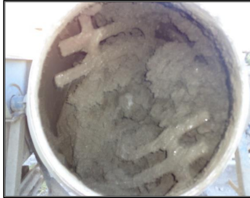
Figura 28. Mezclado del hormigón
