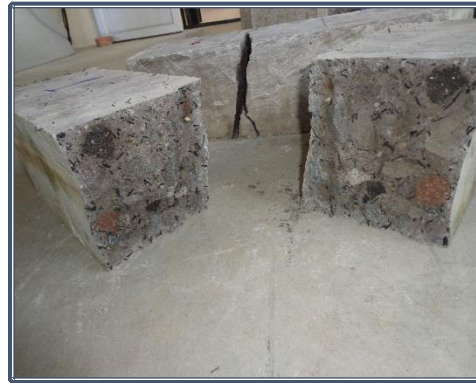
Fotografía 8.80: Composición del hormigón modificado
