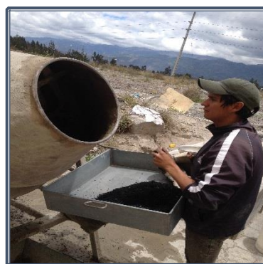
Fotografía 8.16: Colocación de FRN para la obtención de hormigón modificado
