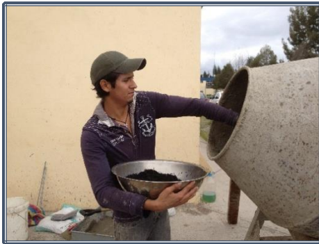
Fotografía 6.9: Colocación de FRN para la obtención del hormigón modificado
