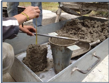
Fotografía 8.19: Control del asentamiento en hormigón modificado
