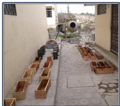
Fotografía 8.51: Ubicación de modos para vertido de hormigón
