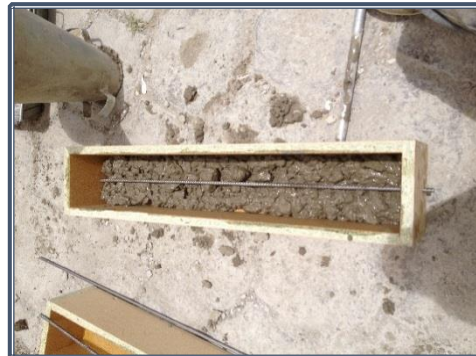
Fotografía 6.10: Vertido de hormigón modificado en moldes.
