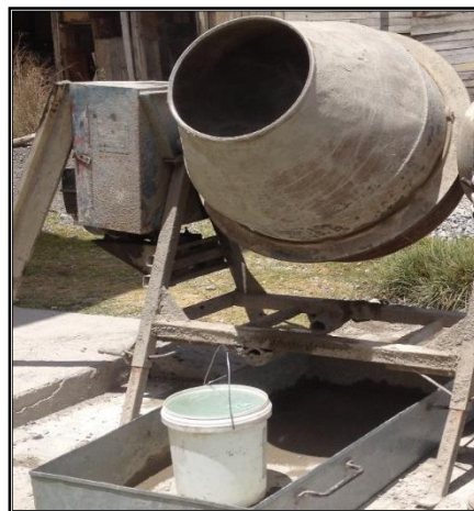
Figura 21. Colocar los 2/3 de agua en la concreteira para iniciar la mezcla de hormigón
