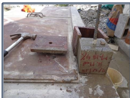
Fotografía 8.65: Desmolde de cubos
