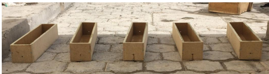
Figura 85. Encofrado para vigas de concreto armado
