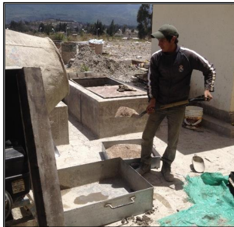
Figura 23. Colocar toda la cantidad de polvo de piedra en concreteira
