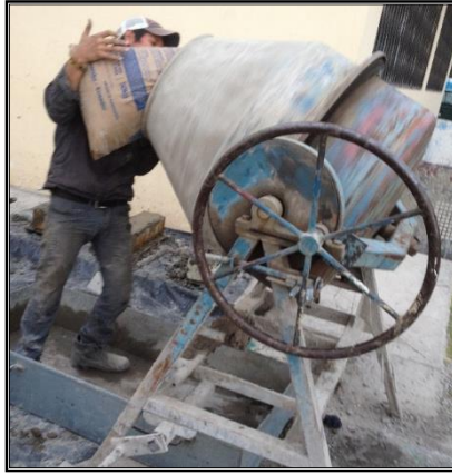
Figura 24. Colocar toda la cantidad de cemento en la concretera
