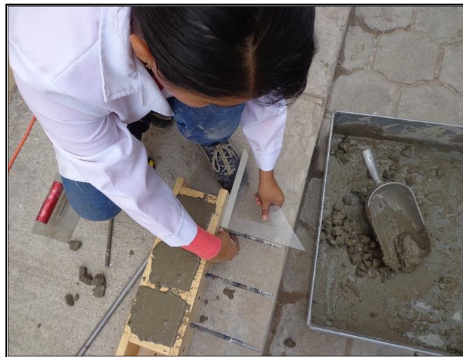
Figura 47. Comprobación de verticalidad de la varilla
