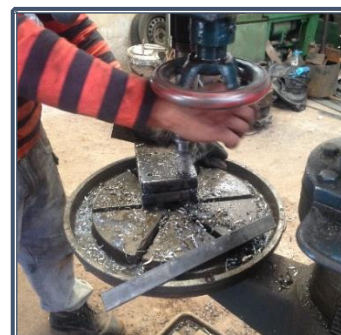
Fotografía 8.36: Perforación de placas.
