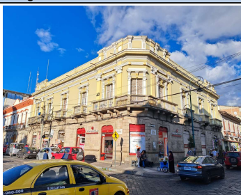
Fotografía No. 1 : Fachada frontal del inmueble
