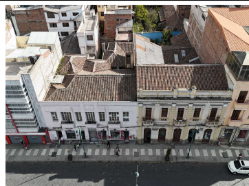
Fotografía No. 2: Tramo donde se ubica el inmueble
