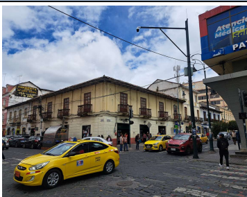
Fotografía No. 1 : Fachada frontal del inmueble
