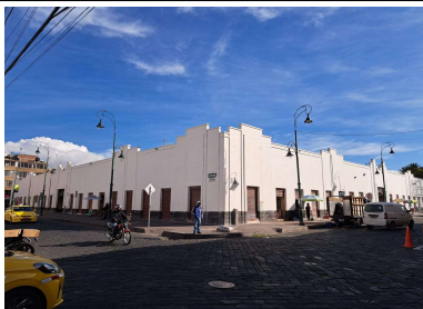
Fotografía No. 1 : Fachada frontal del inmueble
