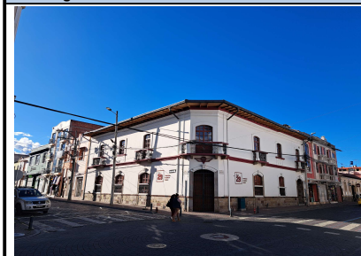
Fotografía No. 1 : Fachada frontal del inmueble
