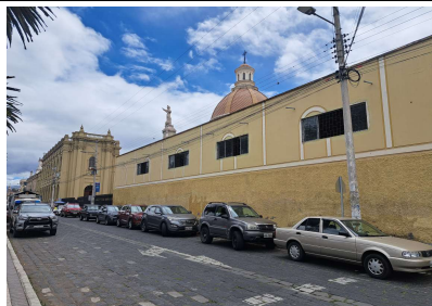
Fotografía No. 2: Tramo donde se ubica el inmueble
