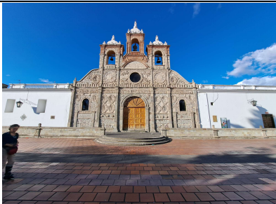
Fotografía No. 1 : Fachada frontal del inmueble
