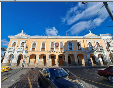
Fotografía No. 1 : Fachada frontal del inmueble
