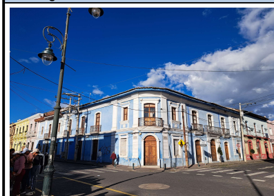
Fotografía No. 1 : Fachada frontal del inmueble
