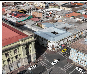
Fotografía No. 2: Tramo donde se ubica el inmueble
