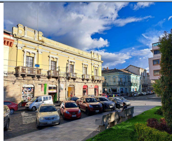
Fotografía No. 2: Tramo donde se ubica el inmueble
