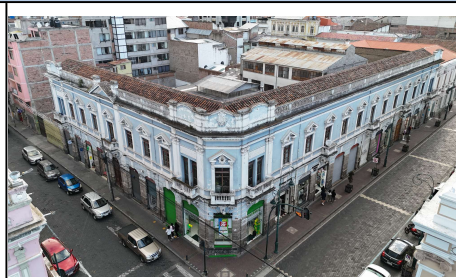
Fotografía No. 2: Tramo donde se ubica el inmueble
