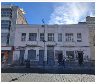
Fotografía No. 1 : Fachada frontal del inmueble
