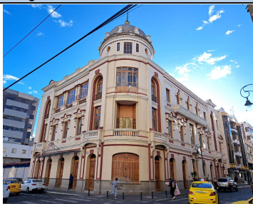
Fotografía No. 1 : Fachada frontal del inmueble
