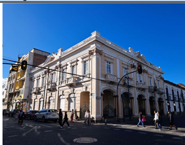
Fotografía No. 1 : Fachada frontal del inmueble
