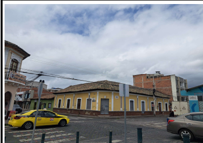
Fotografía No. 1 : Fachada frontal del inmueble
