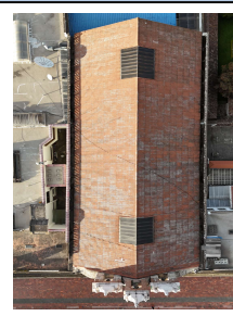
Fotografía No. 3: Vista Cubierta
