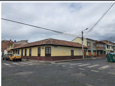
Fotografía No. 1 : Fachada frontal del inmueble
