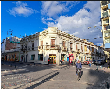
Fotografía No.1 : Fachada frontal del inmueble
