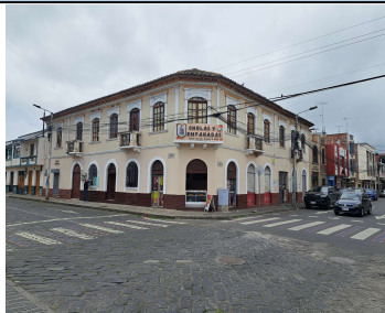
Fotografía No. 1 : Fachada frontal del inmueble
