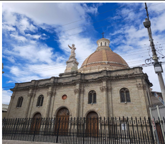
Fotografía No. 1 : Fachada frontal del inmueble
