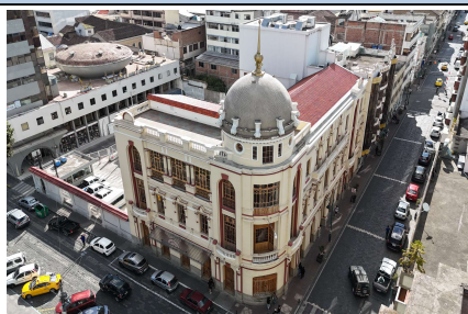
Fotografía No. 2: Tramo donde se ubica el inmueble
