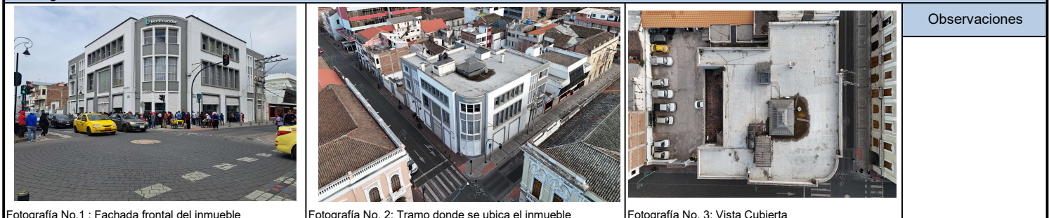
Fotografía No. 1 : Fachada frontal del inmueble
