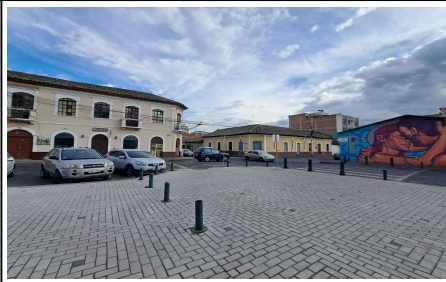
Fotografía No. 2: Tramo donde se ubica el inmueble
