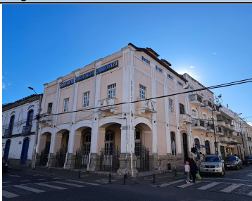
Fotografía No. 1 : Fachada frontal del inmueble
