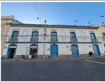
Fotografía No. 1 : Fachada frontal del inmueble
