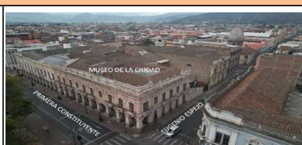
Fotografía No. 2: Tramo donde se ubica el inmueble Código de la fotografía: AC002
