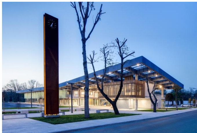
Figura 35: Terminal terrestre de autobuses LULEBURGAZ
