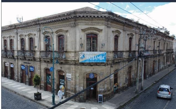
FOTOGRAFÍA DEL INMUEBLE
