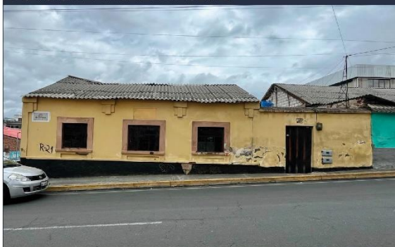
FOTOGRAFÍA DEL INMUEBLE
