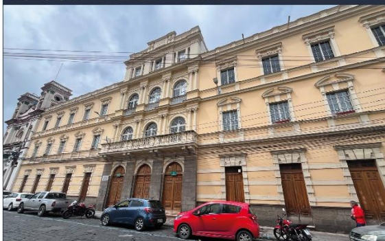
FOTOGRAFÍA DEL INMUEBLE
