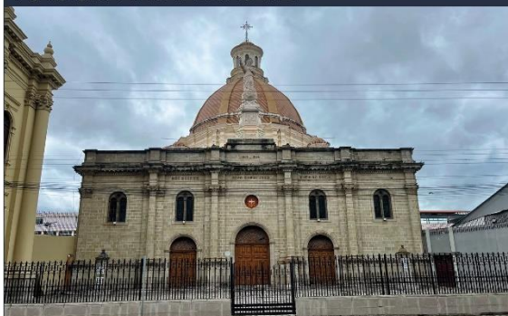
FOTOGRAFÍA DEL INMUEBLE
