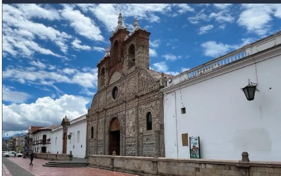
FOTOGRAFÍA DEL INMUEBLE
