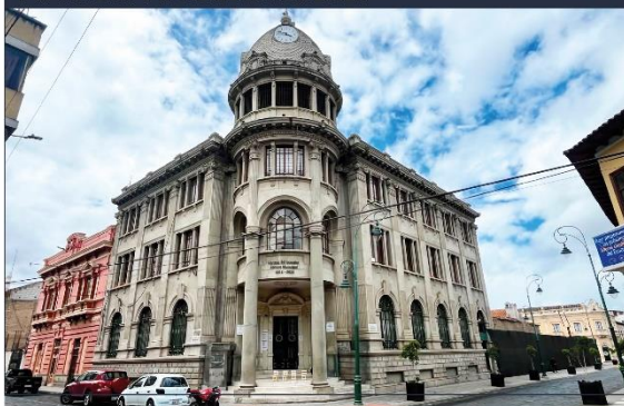
FOTOGRAFÍA DEL INMUEBLE
