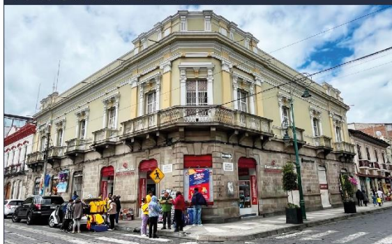
FOTOGRAFÍA DEL INMUEBLE
