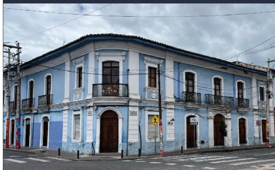
FOTOGRAFÍA DEL INMUEBLE
