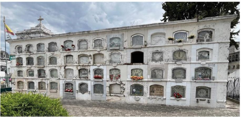
IMAGEN. FACHADA FRONTAL BLOQUE DE NICHOS FUENTE: ELABORACIÓN PROPIA
