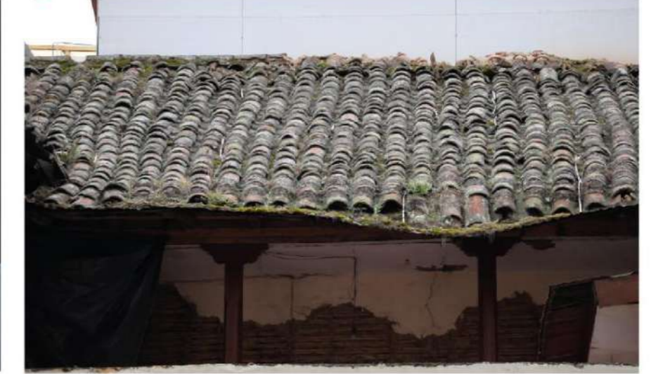
4 Estado de cubierta
