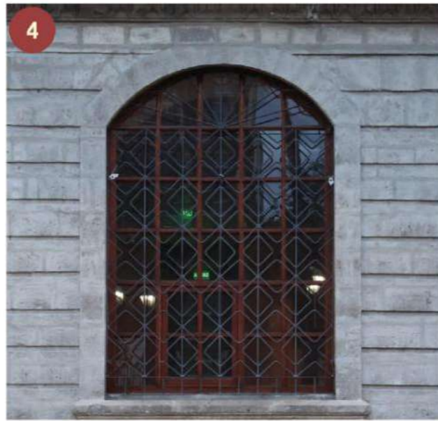
Detalle de vano lateral
