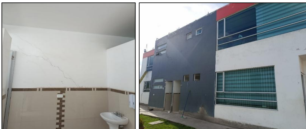
Figura 65. Área de aseo
