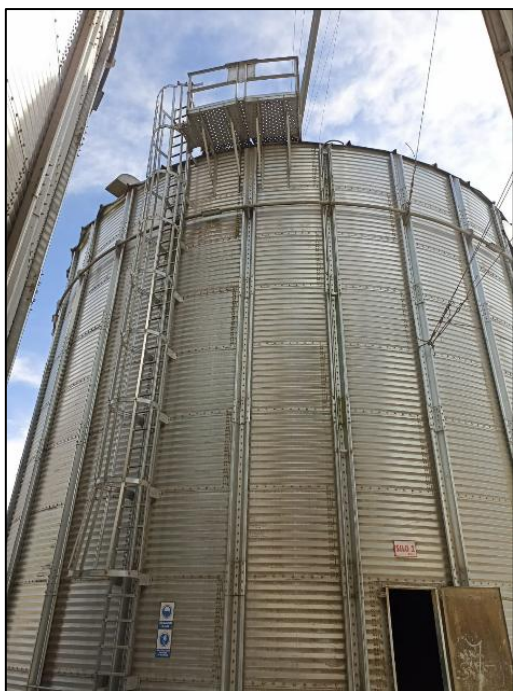
Figura 61. Silos de Biomax
