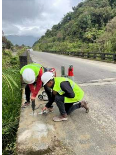
Figura 9: Anclaje del extractor de núcleos al elemento con pernos mecánicos.
