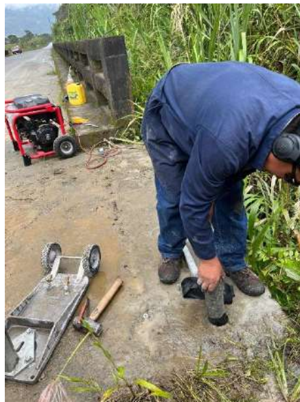
Figura 12: Núcleo extraído.
