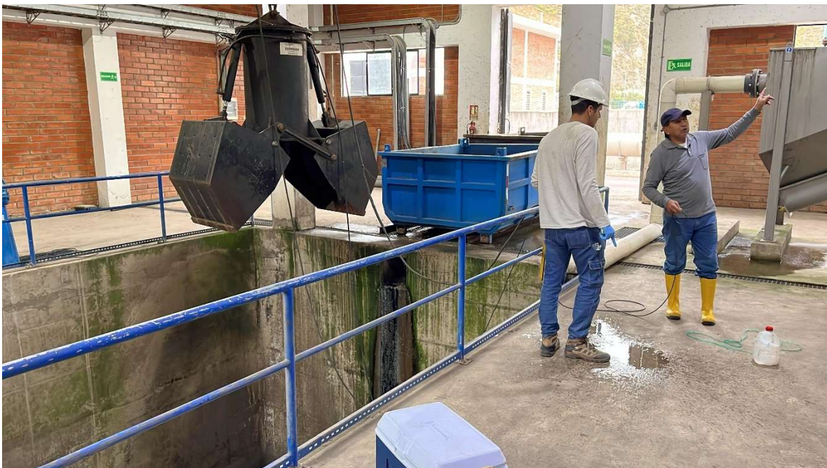
Anexo 10 Punto de muestreo en rejillas y pozo de gruesos
