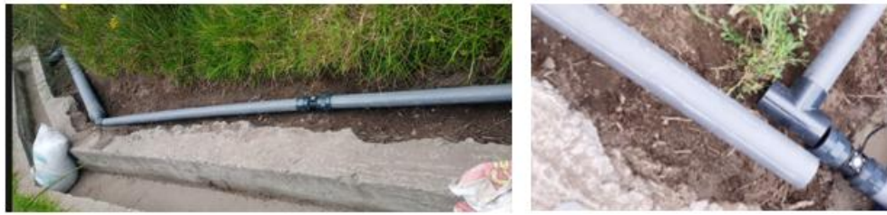
Figura 37. Instalación de tubería y T.
