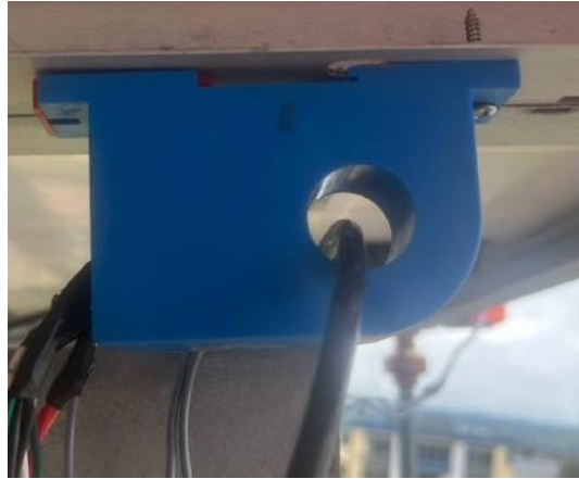
Figura 40. Sensor de corriente JDK-10-QD
