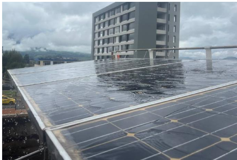
Figura 41. Sistema de enfriamiento
