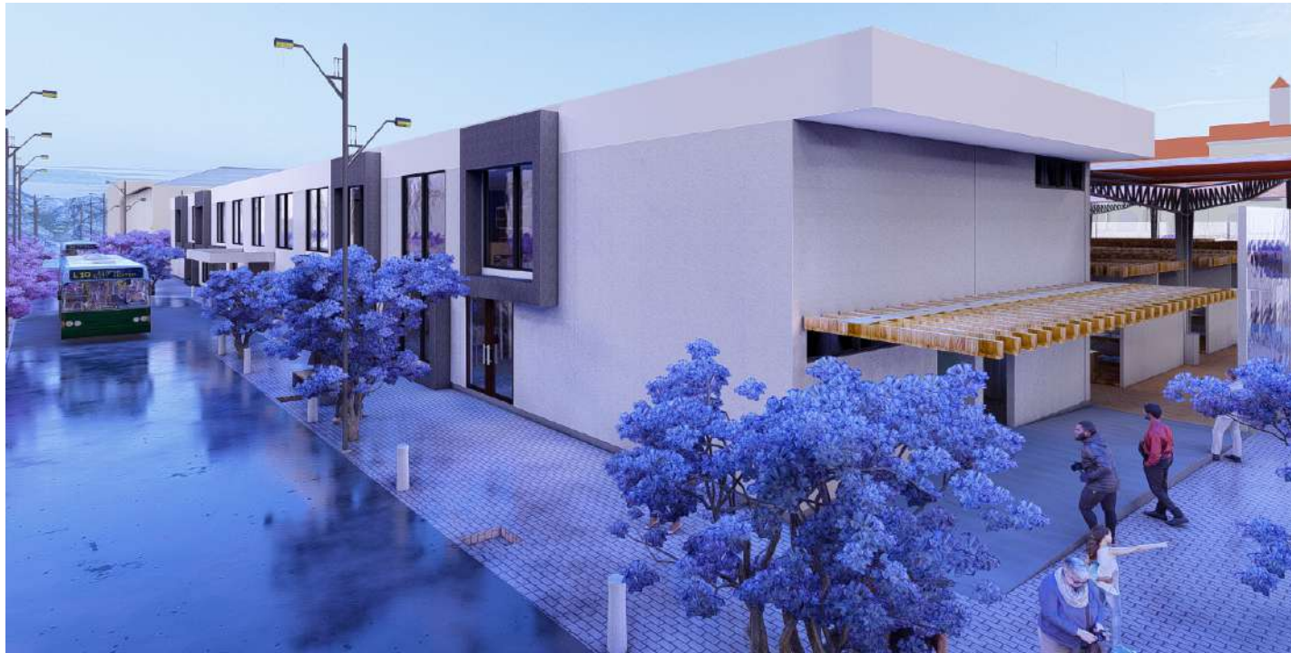
VISTA EXTERIOR DEL BLOQUE CONSTRUIDO
