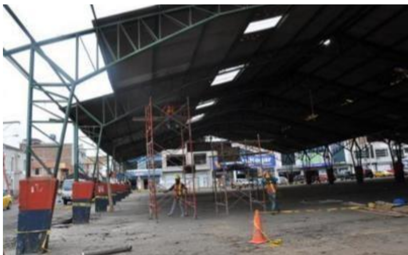
Figura 23. Trabajos de cambio de cubierta en el mercado, 2014
