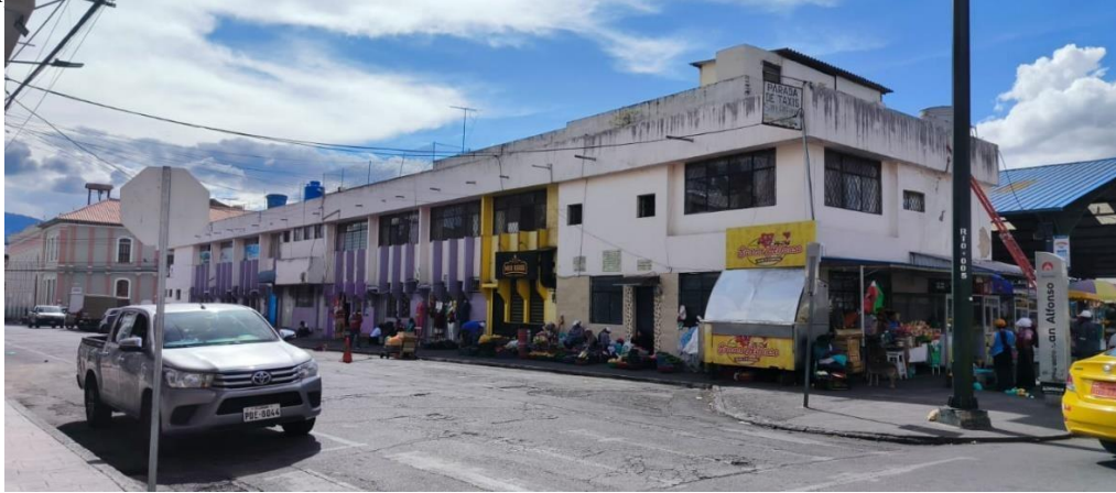
Figura 22. Edificación existente en las calles Tarqui y Junín
