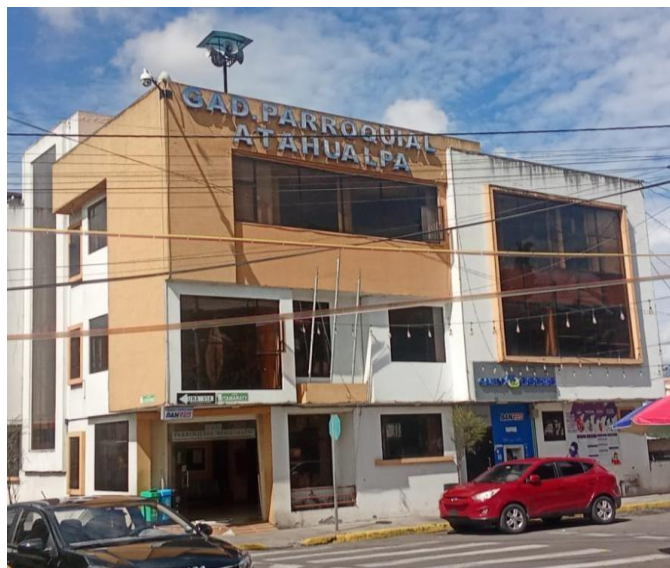
Figura 1 Edificio del Gad Parroquial Atahualpa
