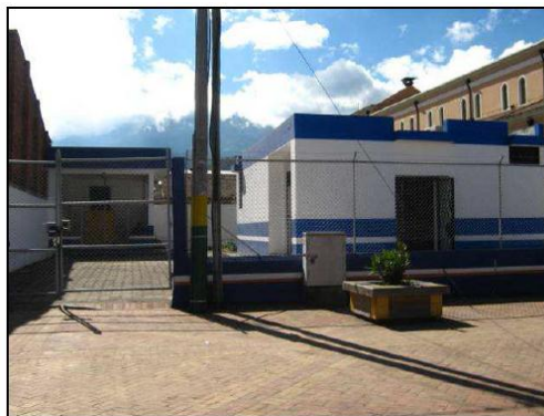
Fotografía 6. Central Telefónica CNT.
