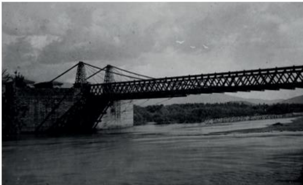
Figura 17 Puente San Juan 1920
