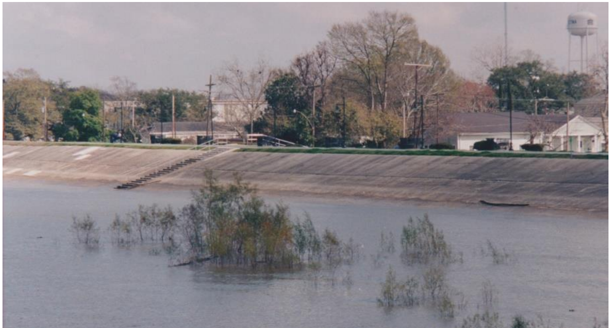
Figura 2 Dique de contención
