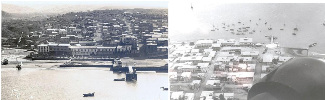
Figura 1 Antiguo puerto de Manta
