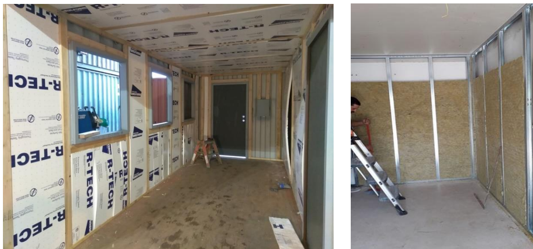
Figura 9. Colocación de Aislantes Dentro de un Contenedor
