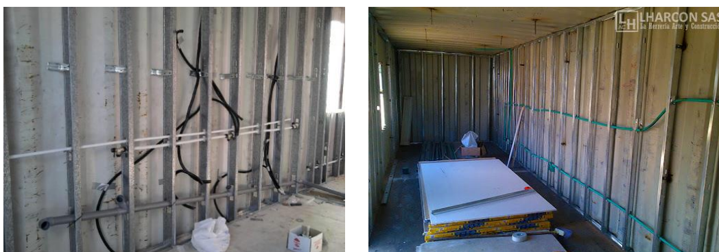
Figura 8. Colocación de Instalaciones en Contenedores
