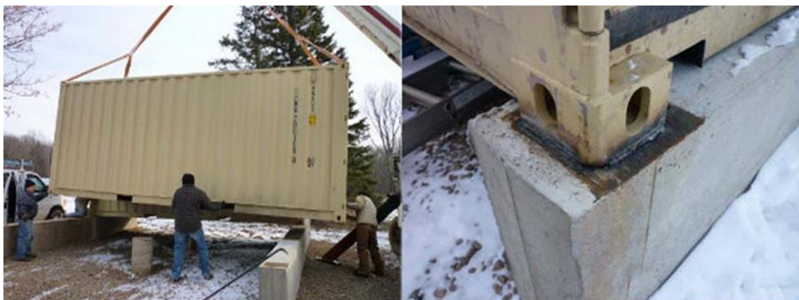
Figura 16. Anclajes y Refuerzos en Contenedores
