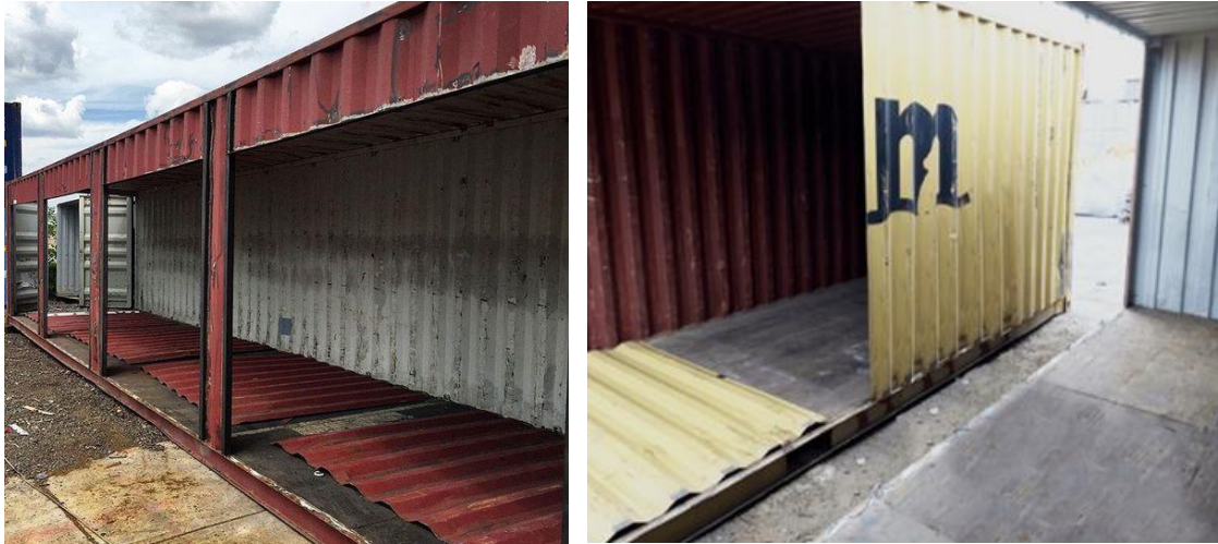
Figura 18. Apertura de Vanos en Contenedores
