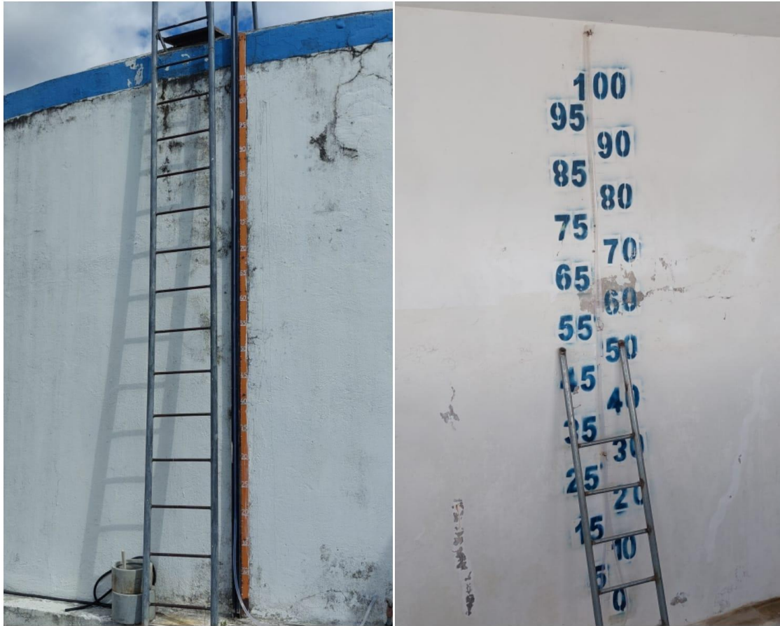
Figura 5. Marcación para medir el porcentaje del nivel de llenado.
