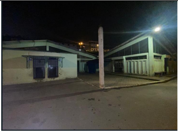
Foto 7: Columnas al medio de la nada
